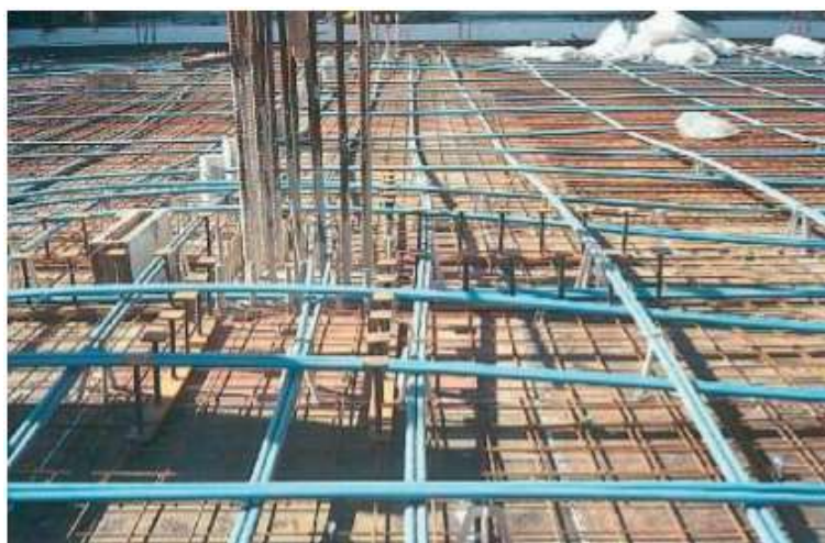
Figura 21 - Laje protendida por cordoalhas engraxadas.
