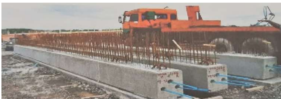
Figura 19 - Vigas com protensão aderente pós tracionada - concretada porém ainda não protendida.
