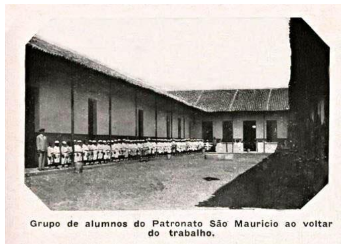
Figura –11 O Pátio do prédio central no tempo de Patronato São Maurício
