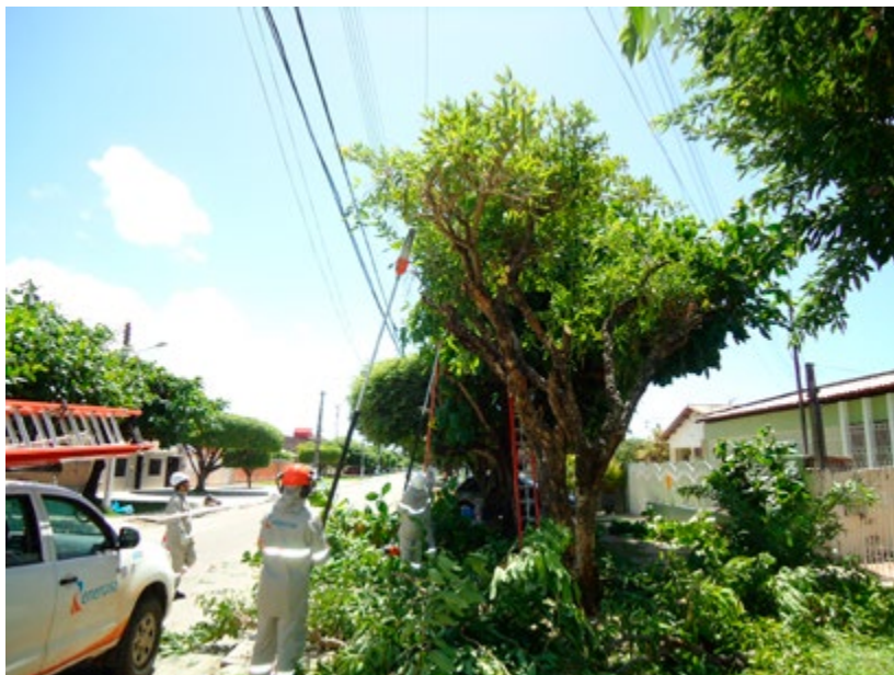
Foto 6 – Poda de segurança em árvore próxima à rede elétrica.
