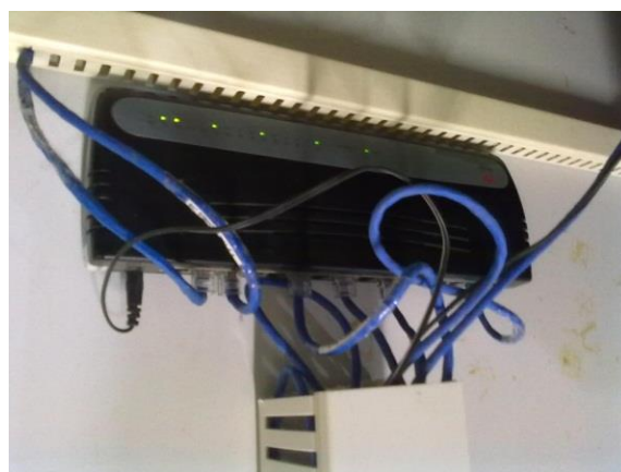
Figura 24 - Distribuição atual do cabeamento horizontal. (Fonte: Autor.)
