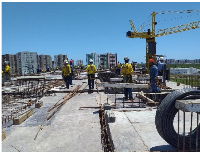
Fotografia 4.4 - Início do posicionamento das armaduras passivas
