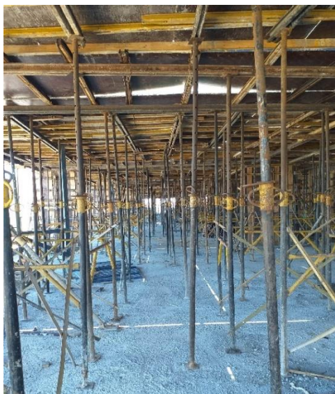
Fotografia 4.2 - Cimbramento do 3º Pav. Tipo (Obra A)
