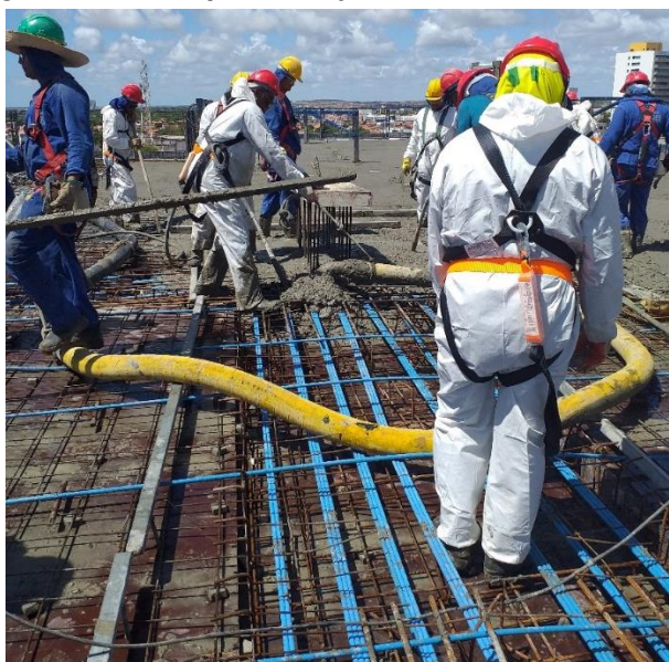
Fotografia 4.9 – Etapa de lançamento e adensamento do concreto
