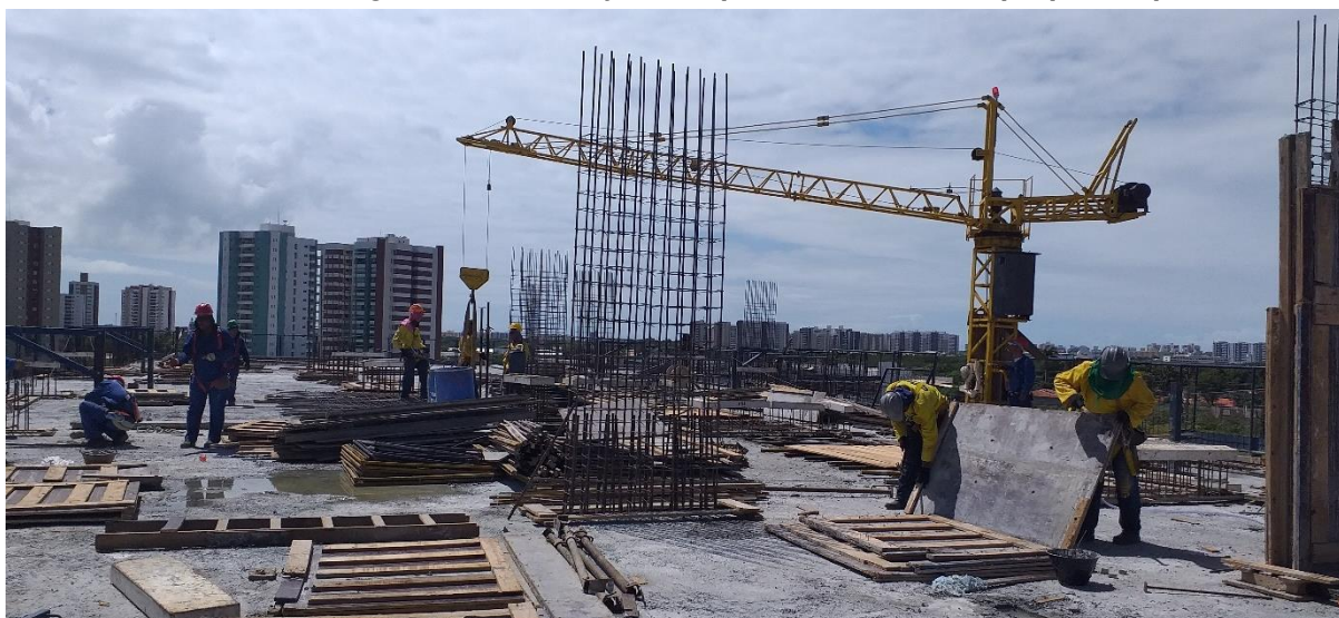
Fotografia 4.3 - Armação dos pilares do 3º Pav. Tipo (Obra A)
