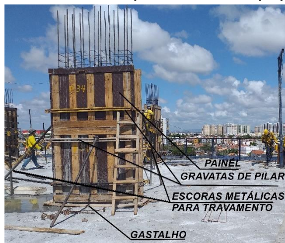
Fotografia 4.1 - Forma dos pilares do 4º Pav. Tipo (Obra A)
