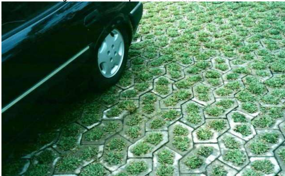
Figura 52: Pavimento permeável em estacionamento.
