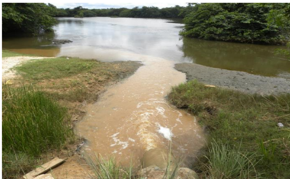
Figura 36: Água pluvial despejada pelo sistema de macrodrenagem no leito do Rio Poxim.
