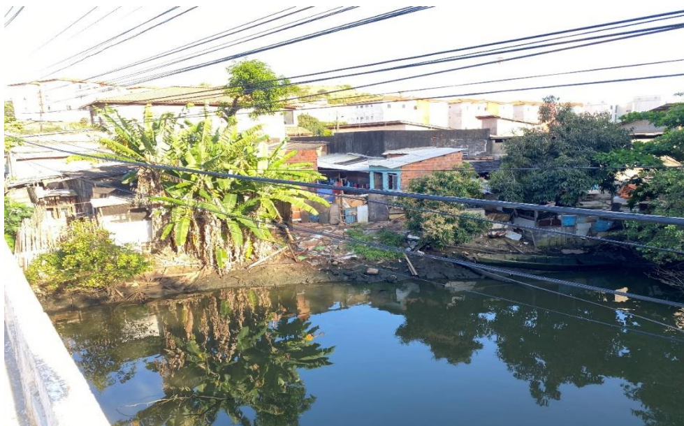
Figura 43: Construções a menos de dois metros do Rio Poxim, na Ponte da “Estrada da Jabotiana”.
