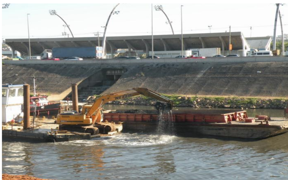
Figura 15: Intervenção pelo leito fluvial, por meio de escavadeira embarcada, no Rio Tietê, em São Paulo/SP.
