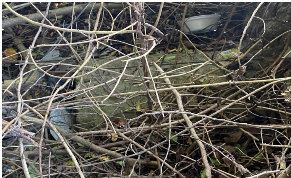
Figura 37: Tubulação de lançamento final de água de um prédio da Rua Jasiel de Brito Côrtes.
