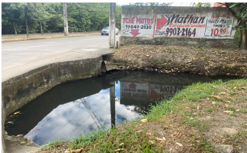
Figura 32: Tubulação de drenagem pluvial com o nível alto de água do canal em época de estiagem.
