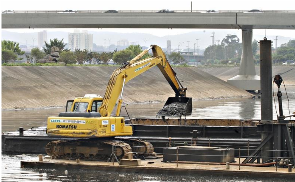
Figura 53: Dragagem do Rio Tietê.
