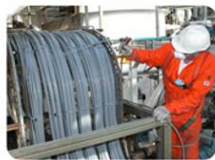
Pintura antichama de Cabos
