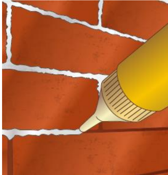
Figura 37 – Aplicação de rejunte.
