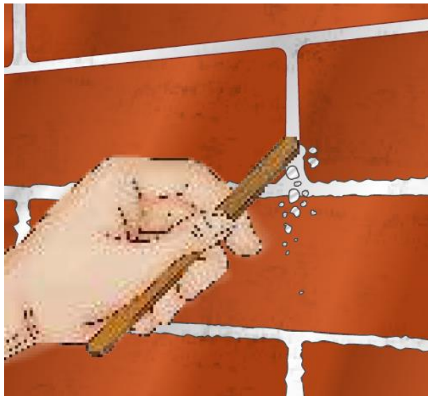
Figura 38 – Utilização de um bastão com pontas arredondadas para acabamento.
