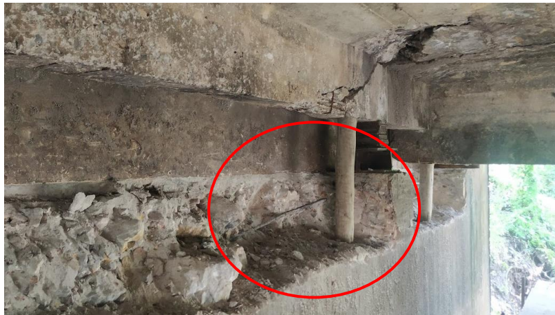
Figura 48 – Concreto com seixo e aço CA-25 no encontro
