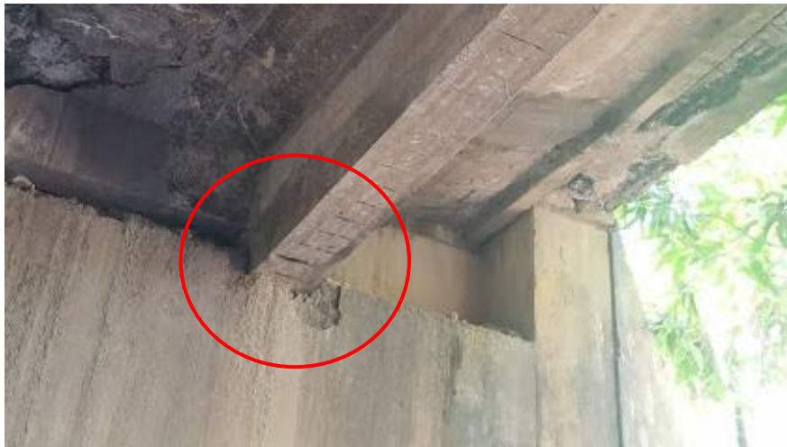
Figura 22 – Deslocamento vertical da longarina
