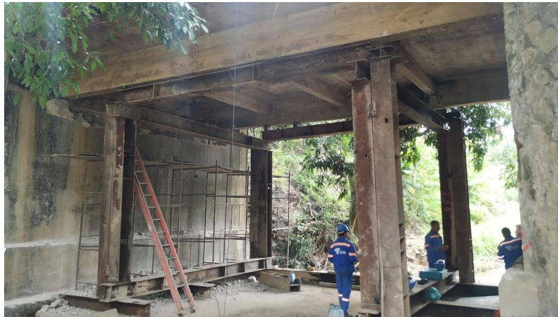
Figura 42 – Execução da obra de recuperação da ponte
