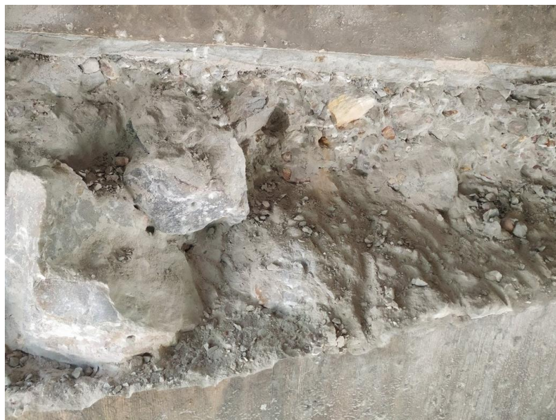
Figura 43 – Remoção do concreto da parte superior do encontro
