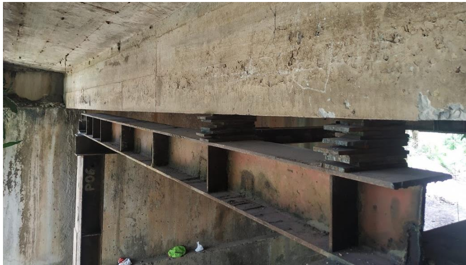
Figura 47 – Detalhe do escoramento da ponte
