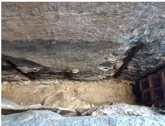
Figura 53 - Área de Reparo
