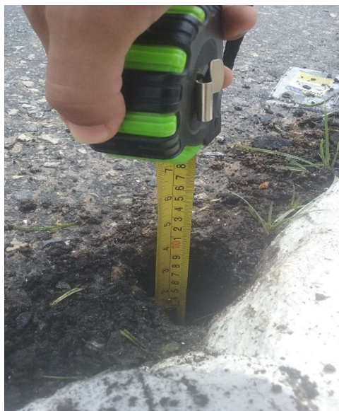
Figura 37 - Furo investigativo no asfalto
