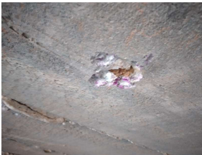
Figura 47 - Ensaio de Profundidade de Carbonatação
