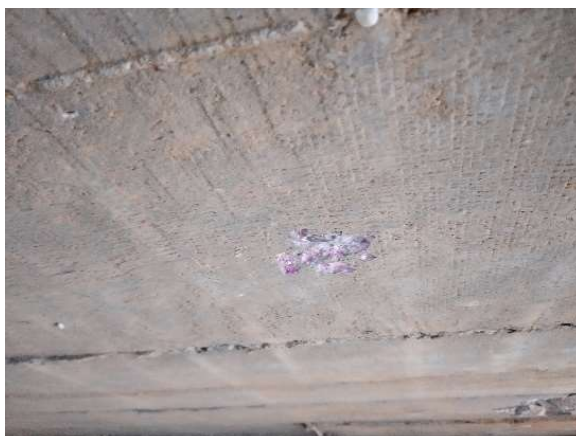
Figura 48 - Abertura (Ensaio de Penetração de Cloretos)
