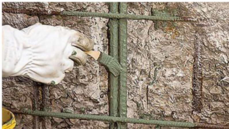
Figura 54 - Tratamento superficial das armaduras
