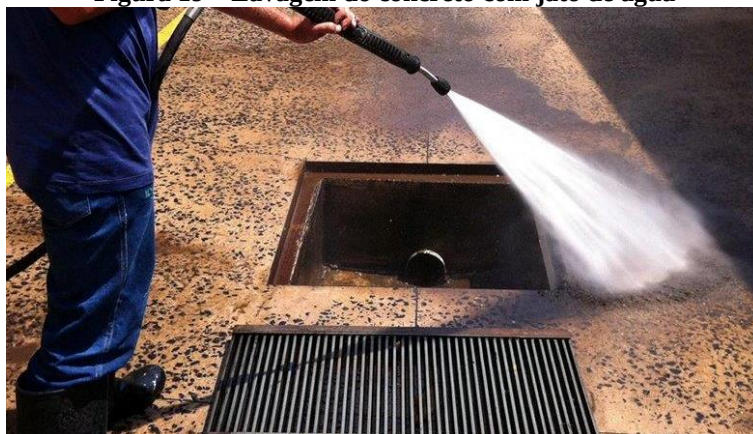
Figura 19 – Lavagem do concreto com jato de água
