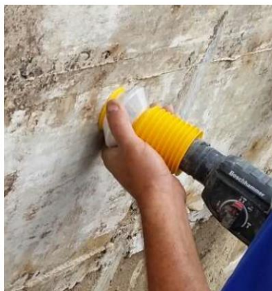
Figura 54 – Determinação da profundidade de carbonatação
