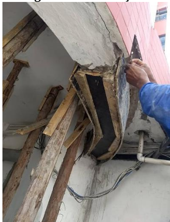
Figura 64 – Execução de fôrmas
