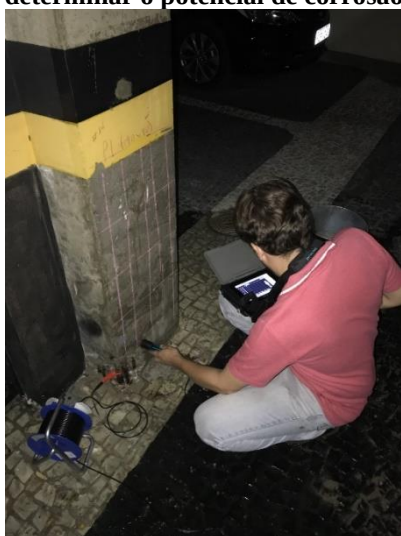
Figura 52 – Contato com a superfície de concreto para determinar o potencial de corrosão
