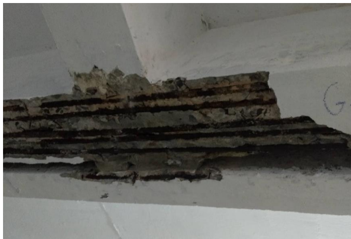
Figura 33 – Vigas da garagem – Ponto G18
