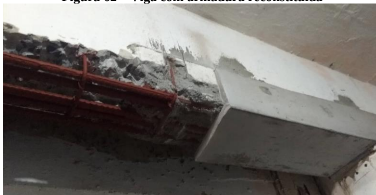
Figura 62 – Viga com armadura reconstituída
