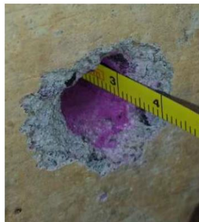
Figura 57 – Determinação da profundidade de carbonatação
