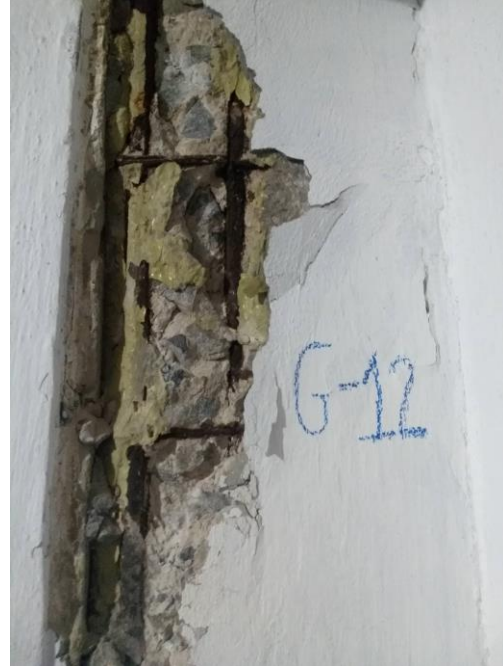
Figura 37 – Pilares da garagem – Ponto G12
