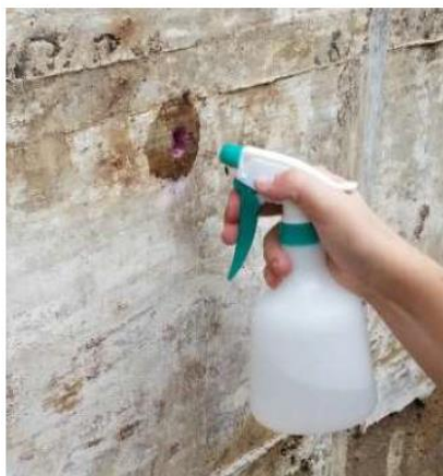
Figura 56 – Determinação da profundidade de carbonatação
