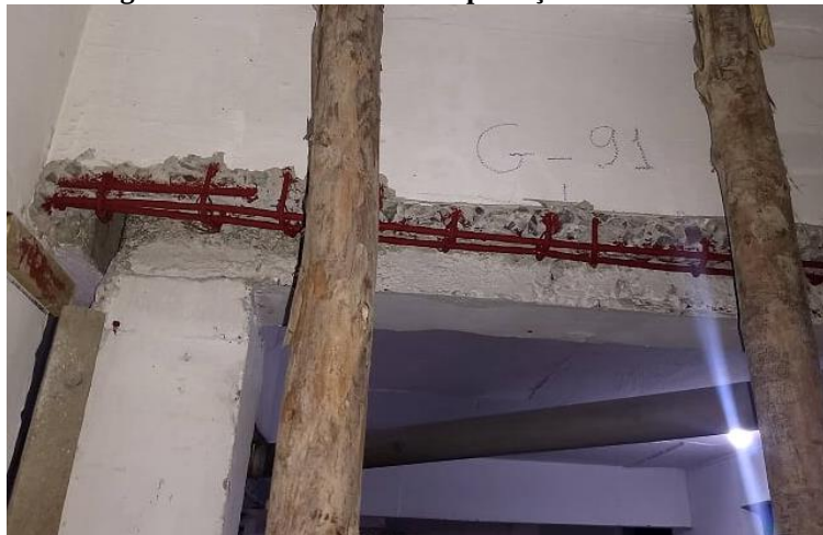
Figura 63 – Armadura com a proteção anticorrosiva
