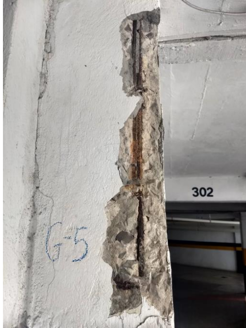
Figura 36 – Pilares da garagem – Ponto G5
