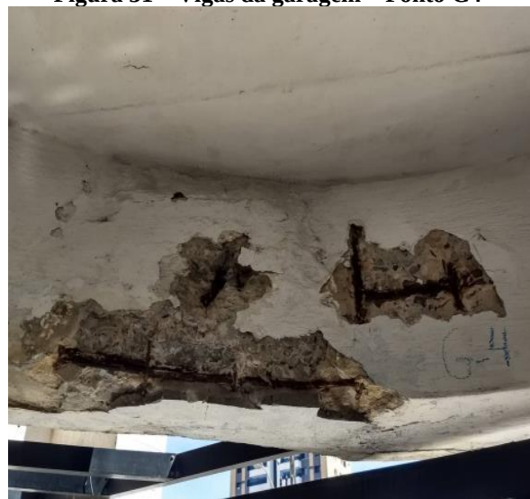
Figura 31 – Vigas da garagem – Ponto G4
