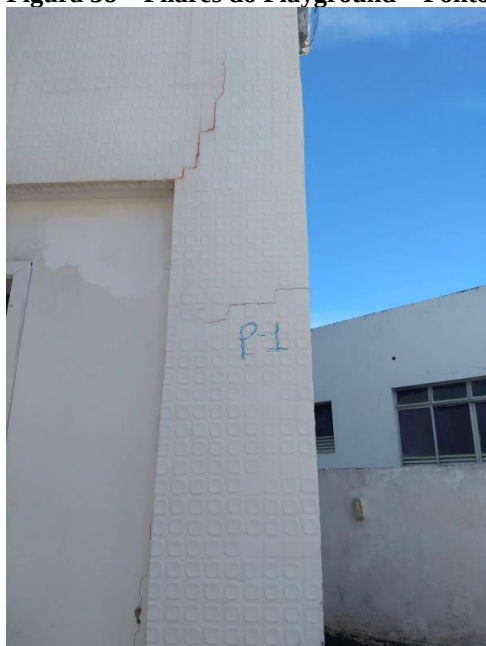
Figura 38 – Pilares do Playground – Ponto P1
