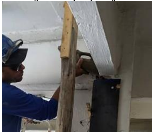
Figura 65 – Aplicação de grout
