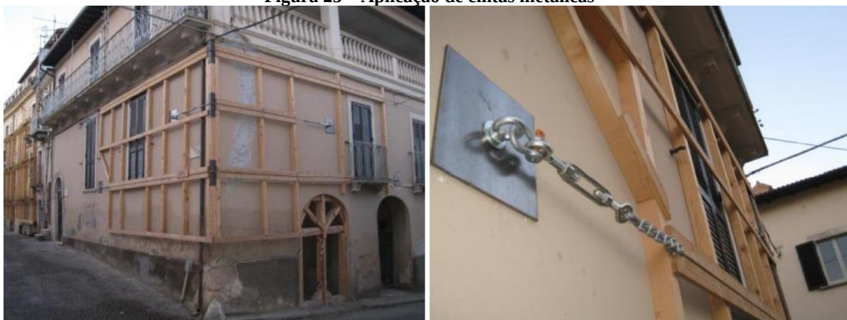
Figura 25 – Aplicação de cintas metálicas
