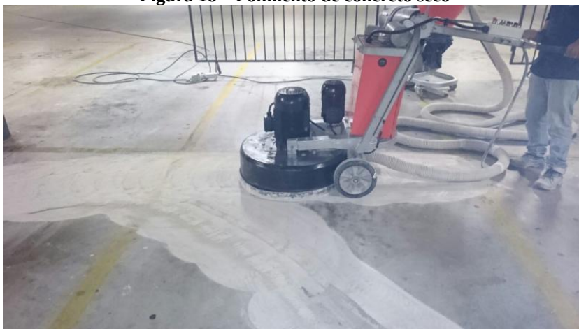
Figura 18 – Polimento de concreto seco
