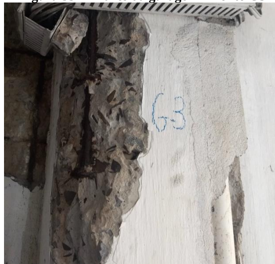
Figura 35 – Pilares da garagem – Ponto G3
