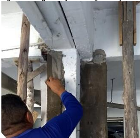
Figura 66 – Regularização com argamassa polimérica
