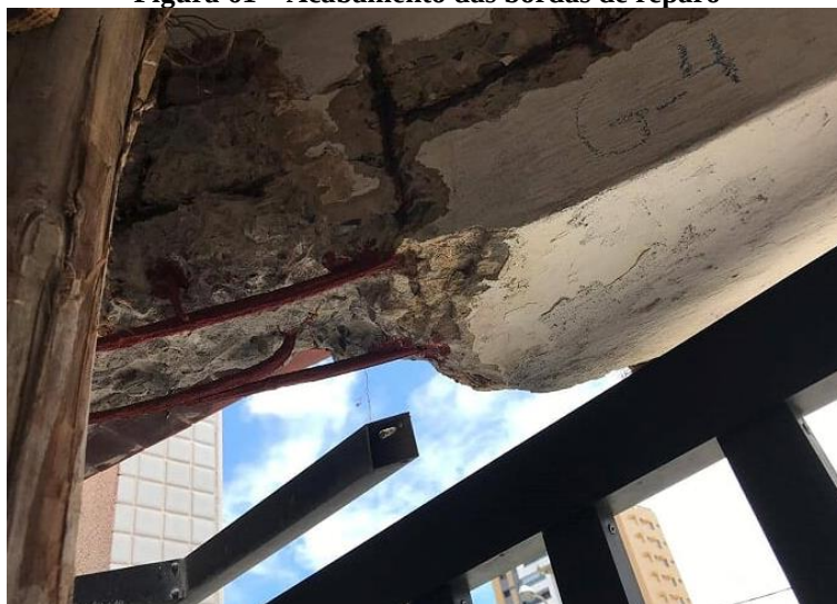
Figura 61 – Acabamento das bordas de reparo
