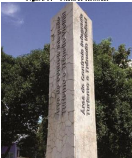
Figura 16 – Fissuras térmicas
