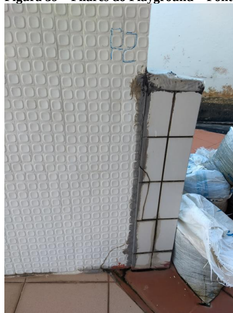
Figura 39 – Pilares do Playground – Ponto P2
