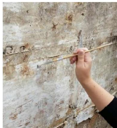
Figura 55 – Determinação da profundidade de carbonatação
