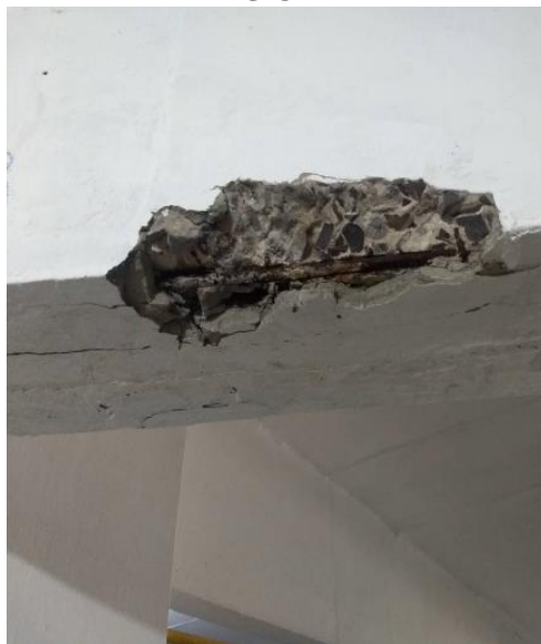
Figura 32 – Vigas da garagem – Ponto G13
