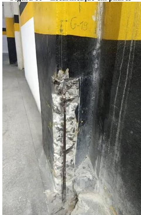
Figura 60 – Escarificação em pilares
