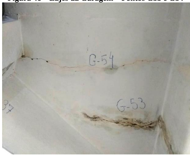
Figura 41 – Lajes da Garagem – Pontos G53 e G54
