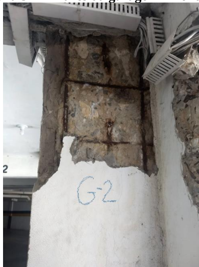
Figura 34 – Pilares da garagem – Ponto G2
