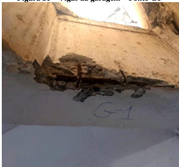
Figura 30 – Vigas da garagem – Ponto G1
