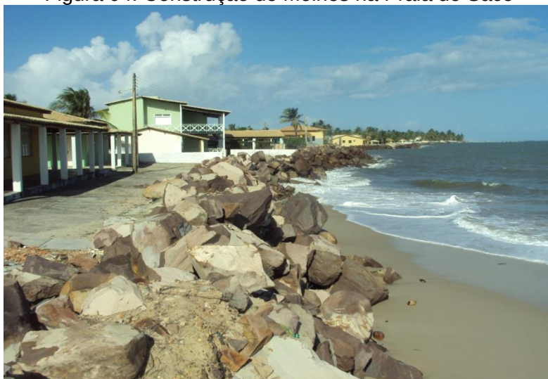
Figura 04: Construção de Molhes na Praia do Saco
