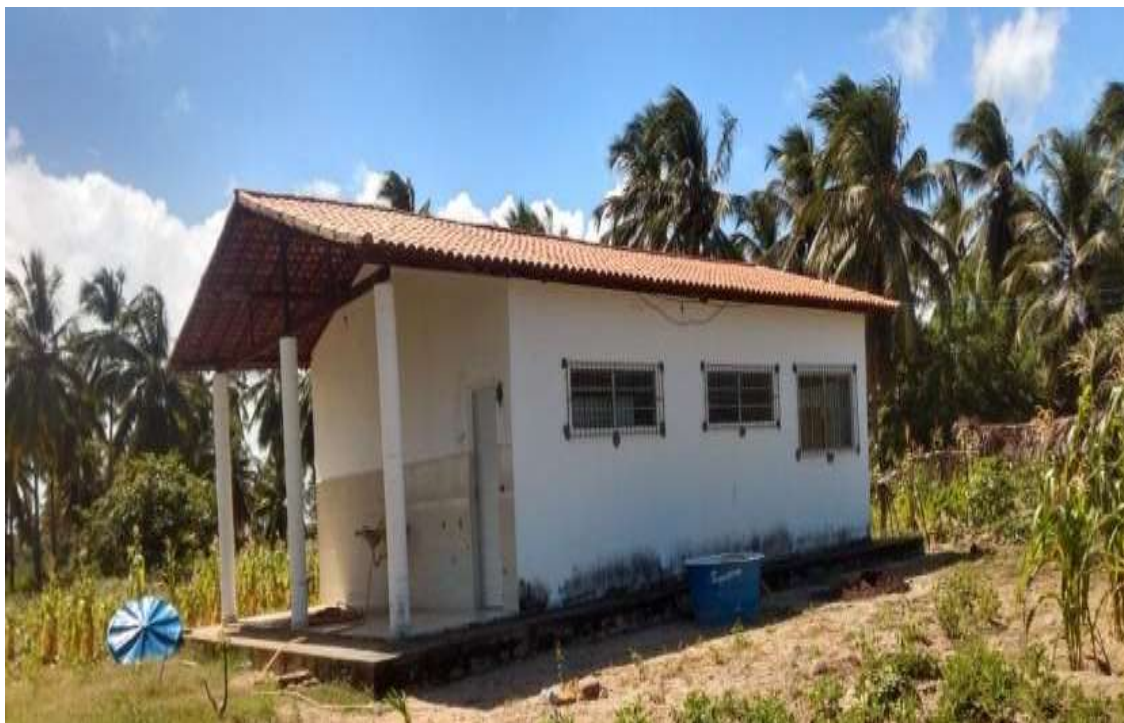
Figura 2: Unidade de Beneficiamento de Coco Construída na Comunidade Quilombola Resina.
