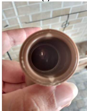
Figura 4.6 — Execução da abertura no “joelho”. (a) Conexão serrado. (b) Furo na tubulação.
