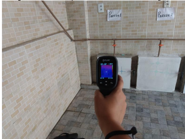
Figura 4.11 — Medição utilizando a câmera termográfica
