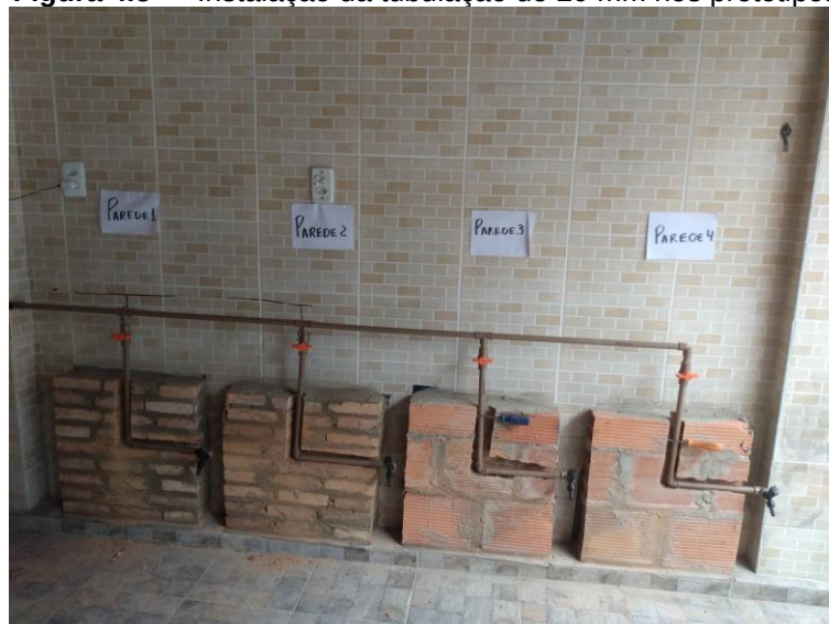
Figura 4.5 — Instalação da tubulação de 20 mm nos protótipos
