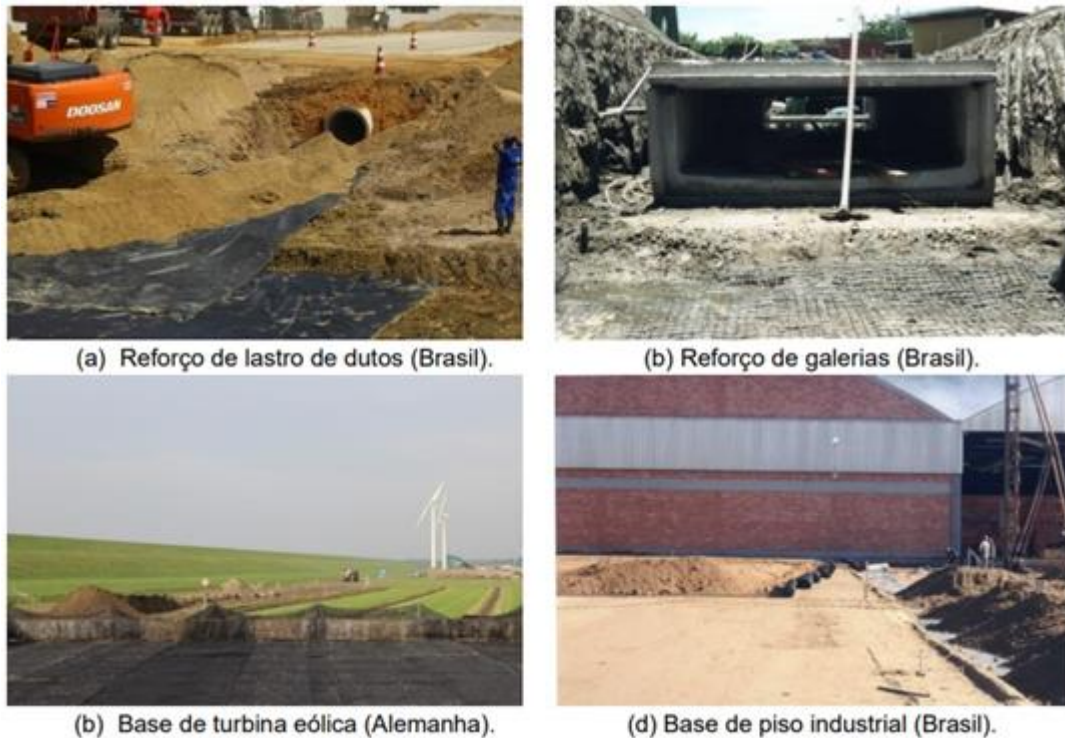
Figura 7: Exemplos de aplicação de reforço de fundações rasas com geossintético
