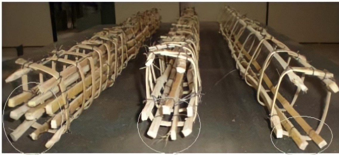
Figura 10 –Armadura de ripas de bambu.
