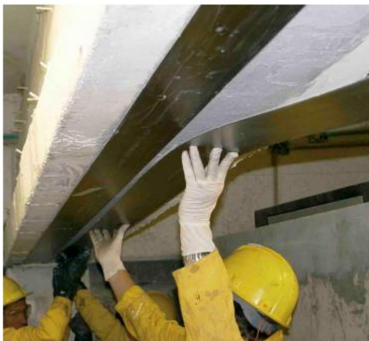
Figura 14 - Aplicação de lâminas de PRFC aplicadas no sistema pré curado.
