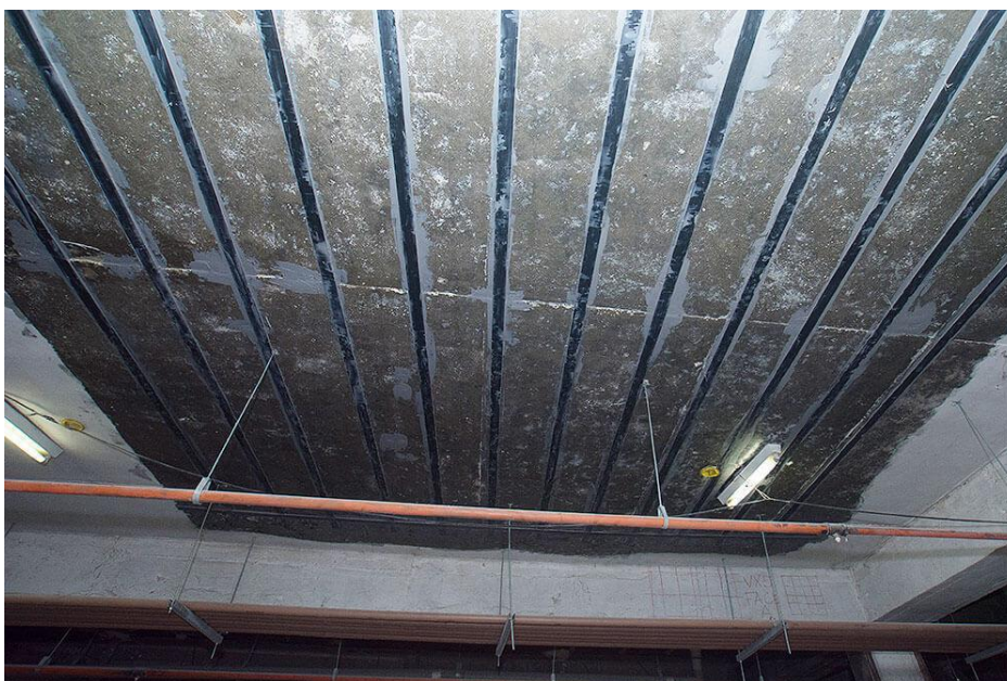
Figura 1 - Exemplo de aplicação de reforço com fibra de carbono em laje.
