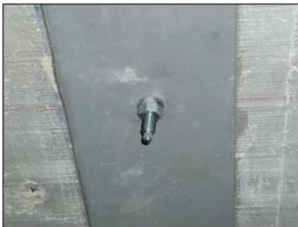
Figura 5- Colocação de buchas expansivas no reforço em lajes.
