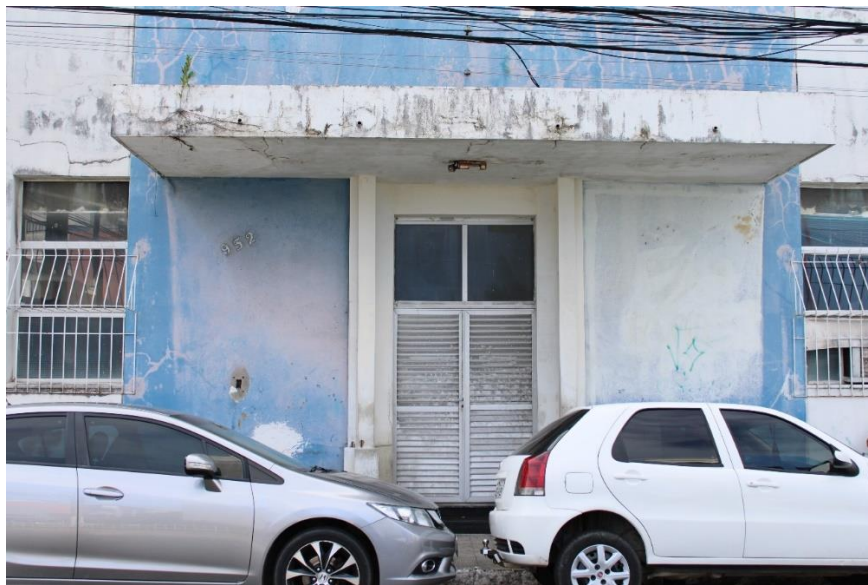
Figura 7: Marquise da UFS engastada em tijolos cerâmicos
