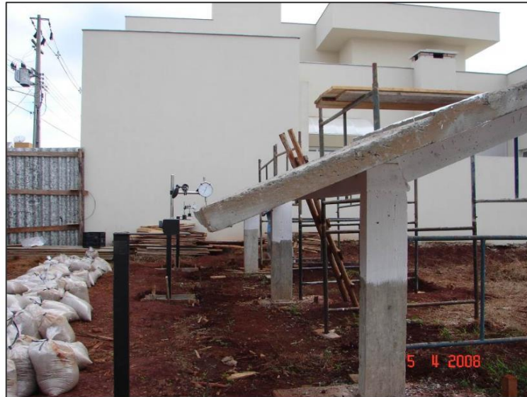
Figura 27: Uso de Relógio comparador na medição da deformação de uma marquise
