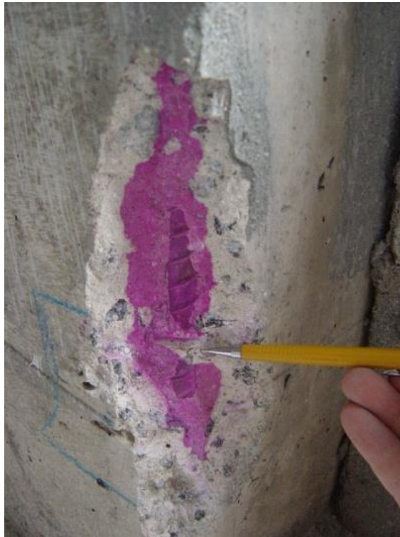
Figura 29: Realização de ensaio de profundidade de carbonatação em concreto
