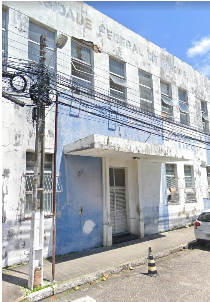
Figura 9: Fotografia mostrando a superestrutura acima do engaste da marquise da UFS
