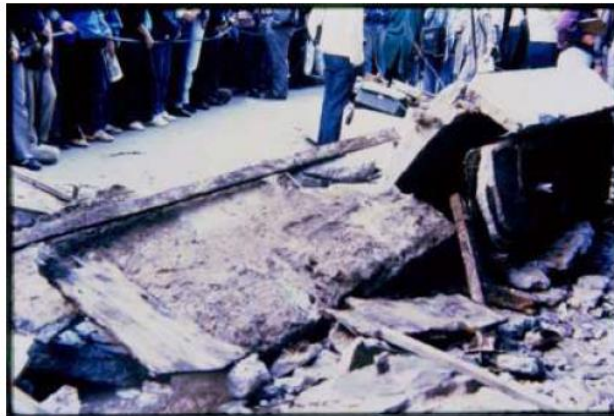
Figura 1: Queda de marquise da filial das Lojas Arapuã em Porto Alegre
