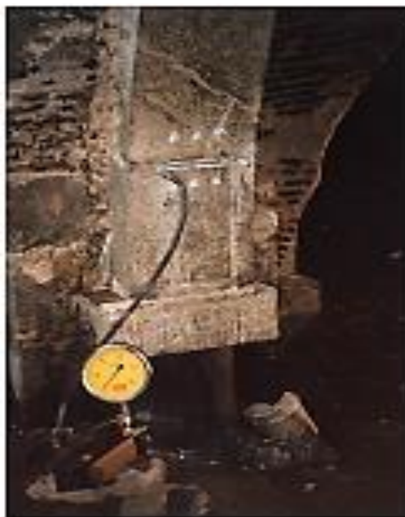
Figura 4 - Posicionamento do macaco plano para o ensaio de determinação do estado de tensão
