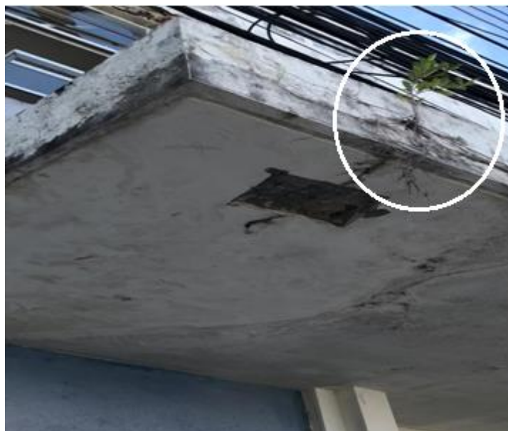
Figura 13 - Presença de vegetação em uma marquise
