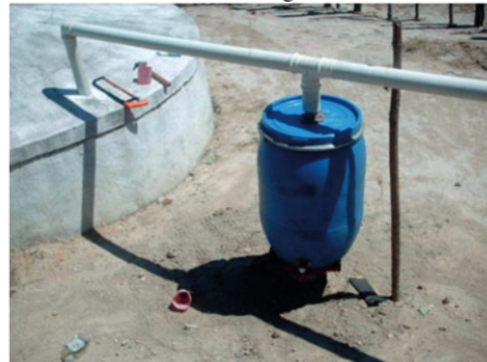
Figura 9 - Dispositivo para o descarte dos primeiros milímetros de água
