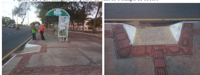
Figuras 22 e 23: Imagens do ponto de ônibus e rampa de acesso
