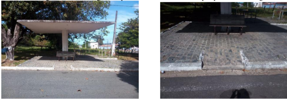
Figura 09 e 10: Imagens do ponto de descanso com rampa apresentando irregularidade.
