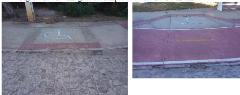
Figuras 24 e 25: Imagens das rampas de acesso na área interna
