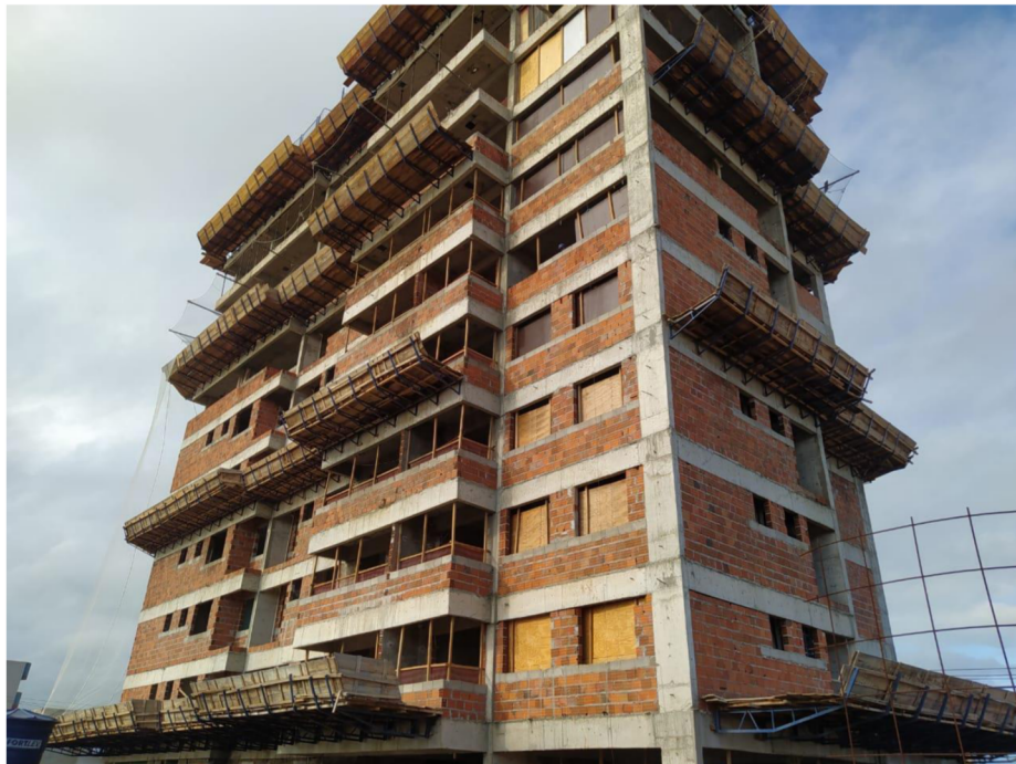
Fotografia 1 – Prédio da edificação em estudo.
