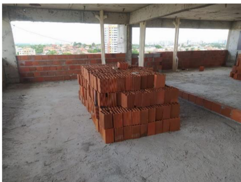
Fotografia 2 – Alvenaria de vedação.
