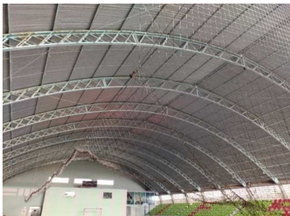
Figura 18 Telhado metálico: prédio 02.
