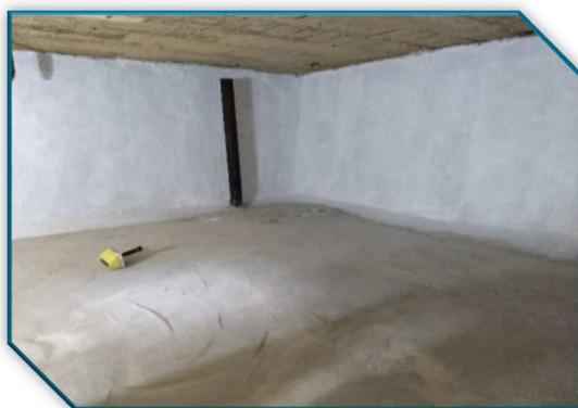
Figura 5 Proteção mecânica do reservatório superior – célula 1
