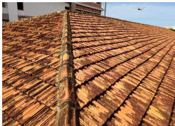
Figura 15 Águas de telhas cerâmica: prédio 09.
