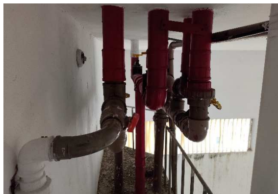
Figura 32 Barrilete - Vista lateral: prédio 12.
