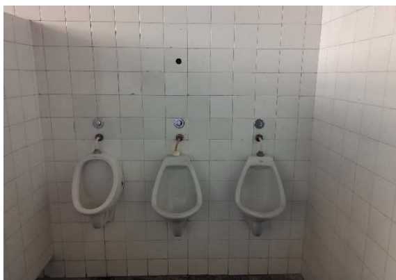
Figura 35 Banheiro - Mictórios: prédio 12.
