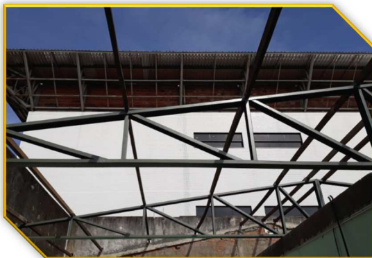
Figura 8 Estrutura metálica de suporte do telhado
