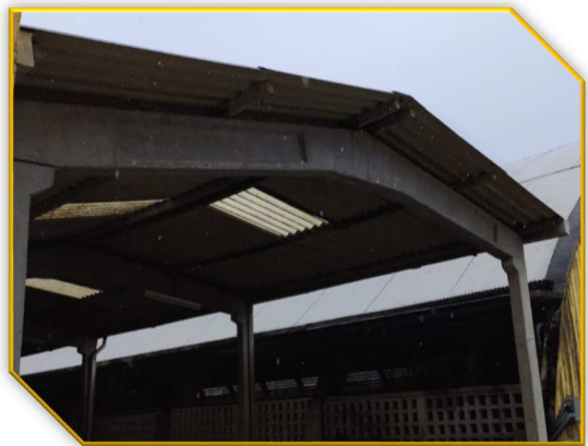
Figura 7 Telhado em estrutura de concreto
