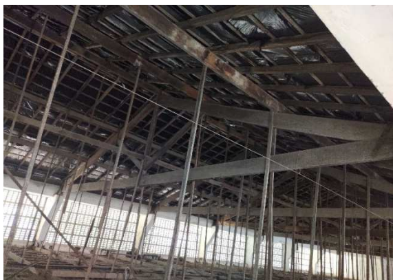
Figura 14 Ático do telhado: prédio 09.
