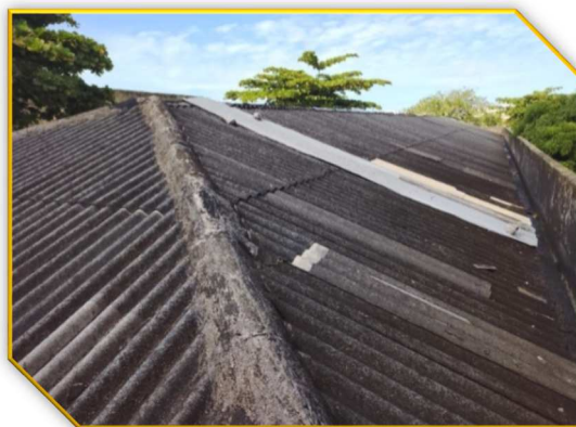
Figura 5 Águas de telhas de fibrocimento
