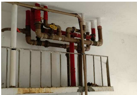
Figura 31 Barrilete - Vista frontal: prédio 12.
