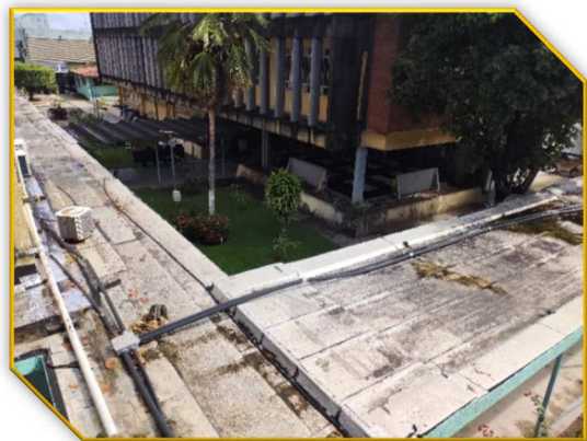
Figura 11 Laje de concreto dos corredores
