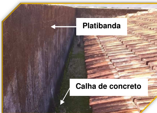
Figura 4 Platibanda e calha
