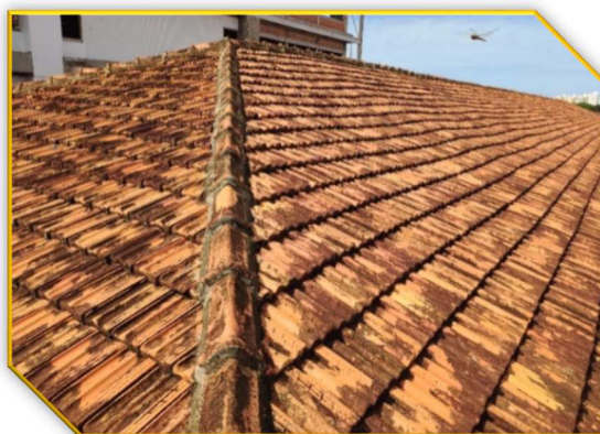
Figura 3 Águas de telhas cerâmica
