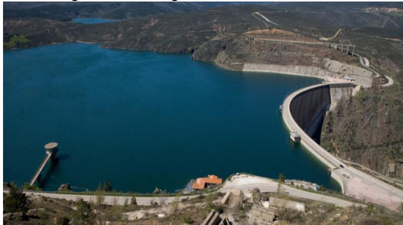
Figura 2 – Barragem de concreto em arco.
