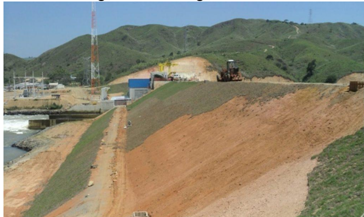
Figura 4 – Barragem de terra.
