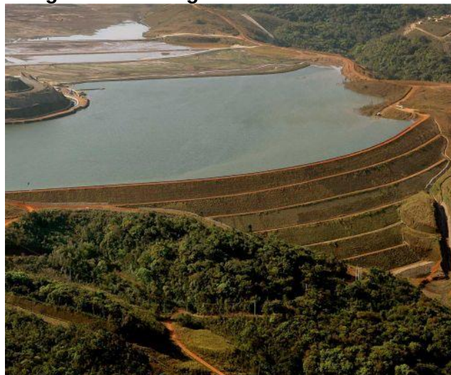
Figura 1 – Barragem de aterro hidráulico.
