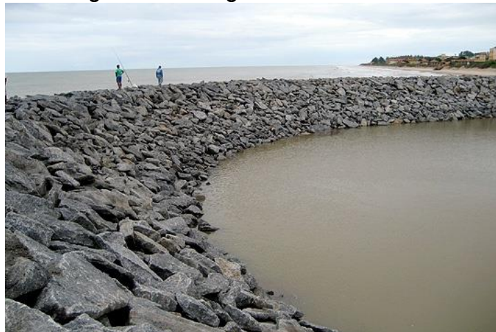
Figura 3 – Barragem de enrocamento.
