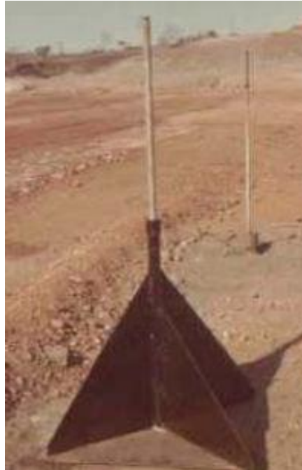
Figura 8 – Placas de recalque.
