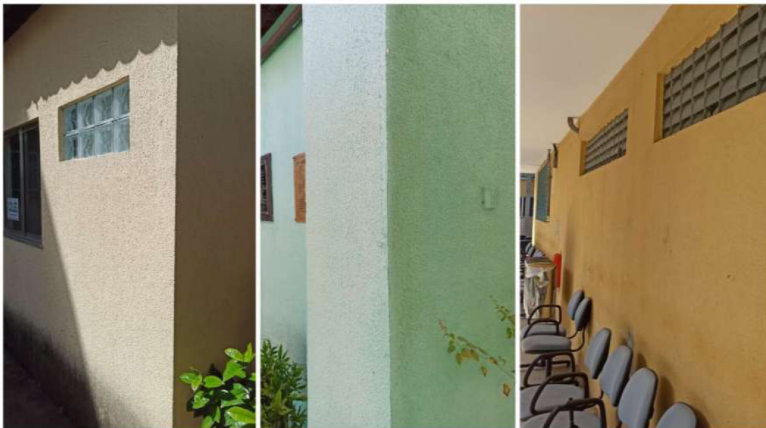
Figura 18 - Revestimento de ambientes externos em argamassa (com pintura).
