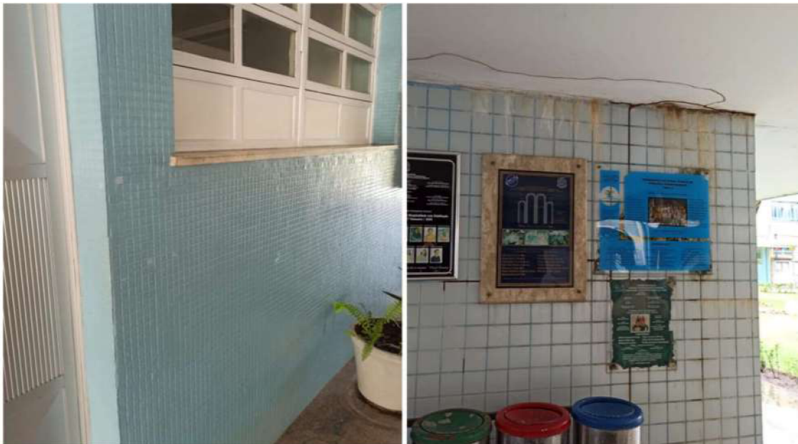
Figura 17 - Revestimento cerâmico de ambientes externos.
