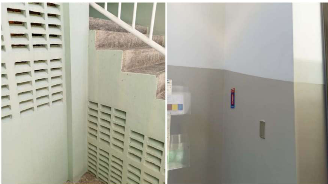
Figura 19 - Revestimento de ambientes internos em argamassa (com pintura).
