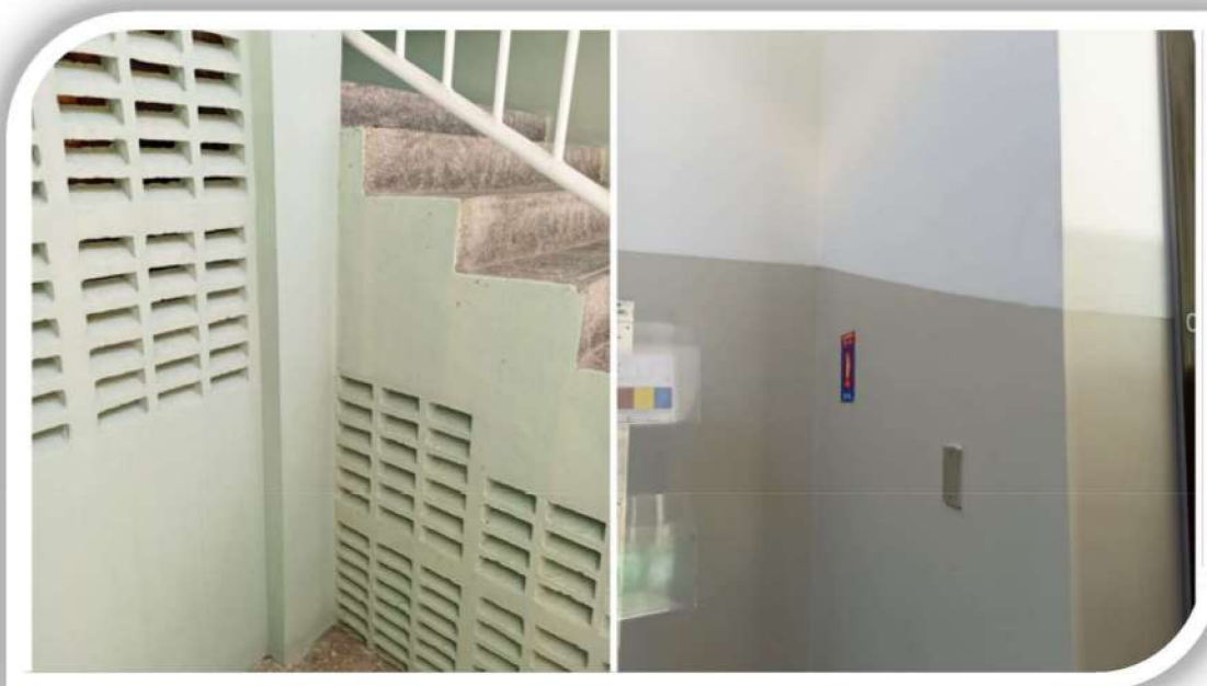
Figura 3: Revestimento de ambientes internos em argamassa (com pintura).
