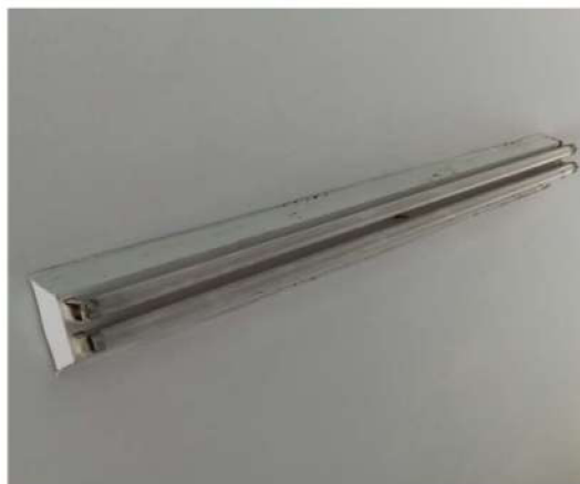
Figura 13 - Luminária fluorescente do corredor.
