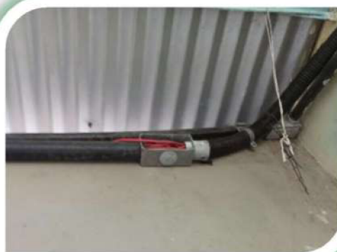
Figura 3: Eletrodutos do ginásio.
