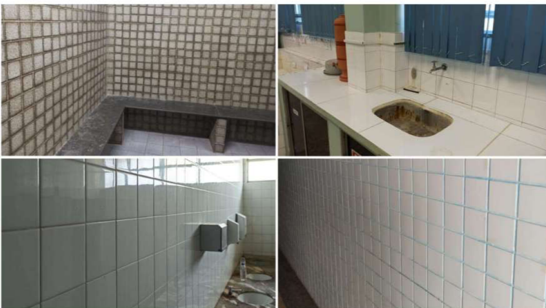
Figura 20 - Revestimento cerâmico de ambientes internos.
