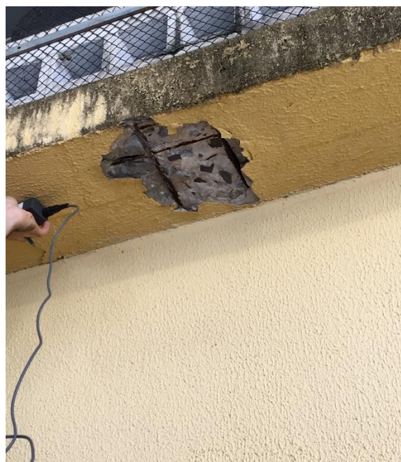
Figura 4.9 – Leitura do cobrimento com o pacômetro (a) e a área escarificada existente (b).
