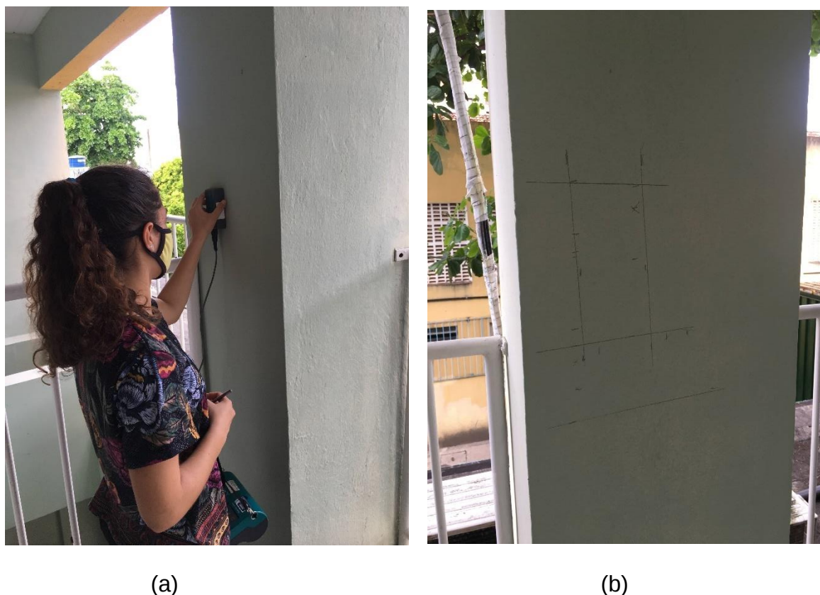
Figura 3.15 – Manuseio do equipamento (a) e localização e marcação das armaduras localizadas (b).
