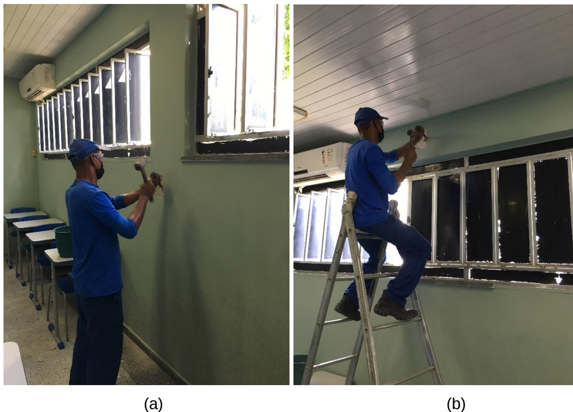
Figura 4.7 – Processo de escarificação do pilar (a) e da viga (b).
