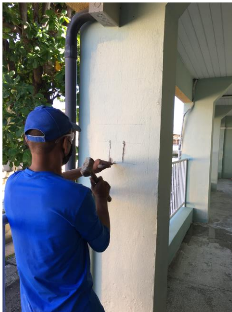
Figura 33 – Processo de escarificação (a) e medição com o paquímetro (b).
