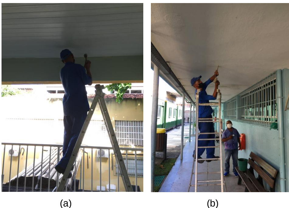
Figura 35 – Escarificação da viga (a) e da laje (b).
