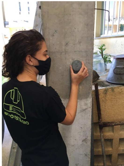
Figura 26 – Preparação da superfície com auxílio da pedra esmeril.
