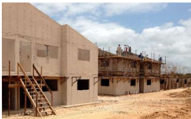
Figura 2 – Paredes de concreto utilizando o sistema Gethal
