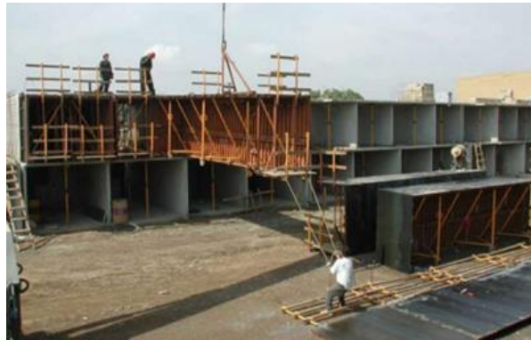
Figura 3 – Paredes de concreto utilizando o sistema Outinord
