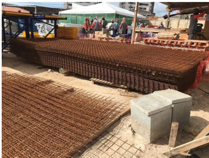
Figura 32 – Armazenamento das telas soldadas
