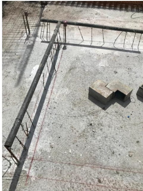
Figura 25 – Marcação de paredes
