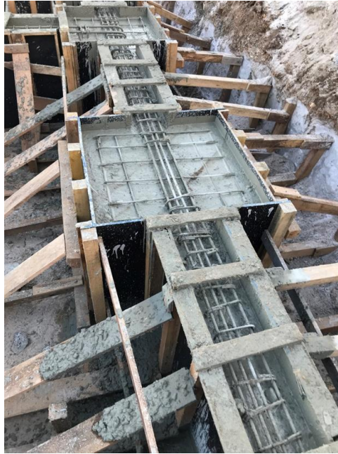
Figura 21 – Blocos de coroamento e vigas baldrames após concretagem
