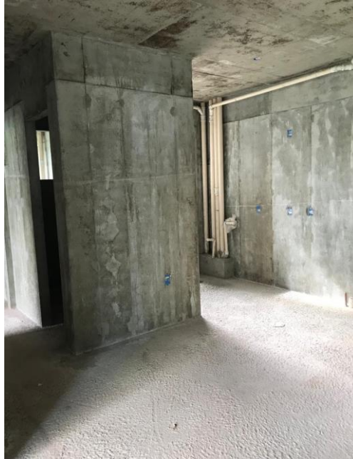
Figura 36 – Paredes desformadas
