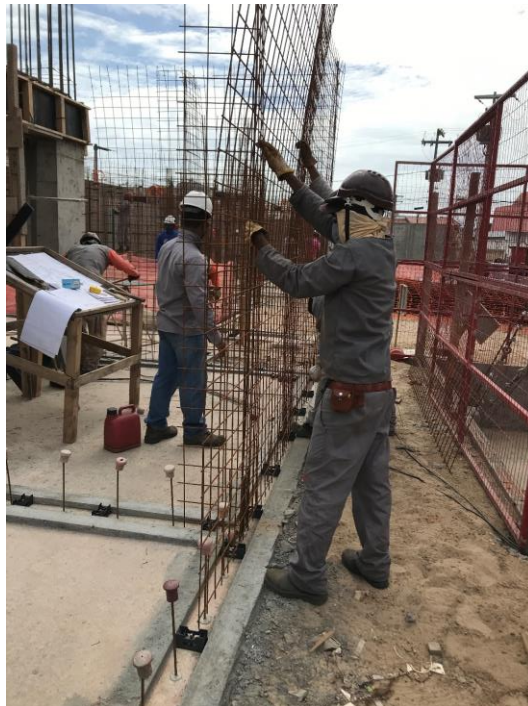
Figura 27 – Posicionamento de telas eletrosoldadas
