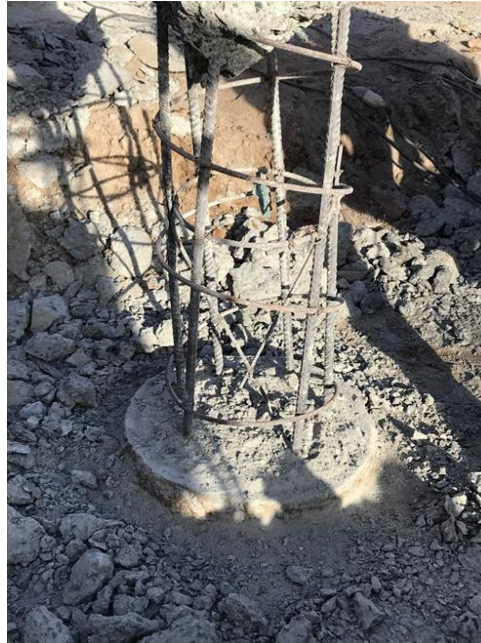
Figura 18 – Estaca após arrasamento
