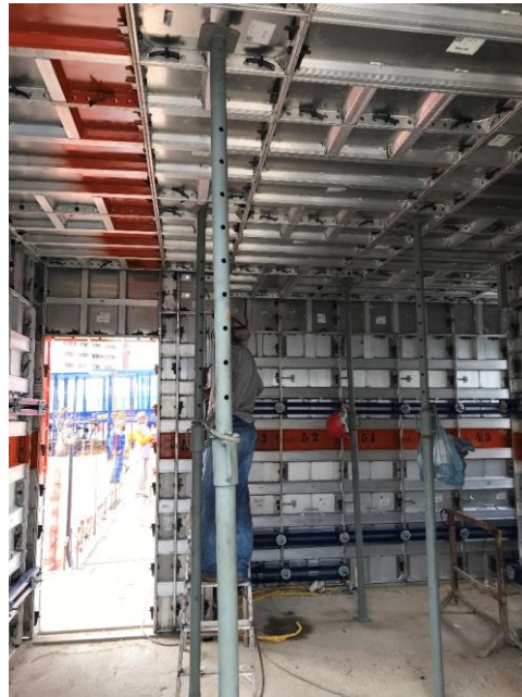
Figura 29 – Fôrmas e escoras metálicas
