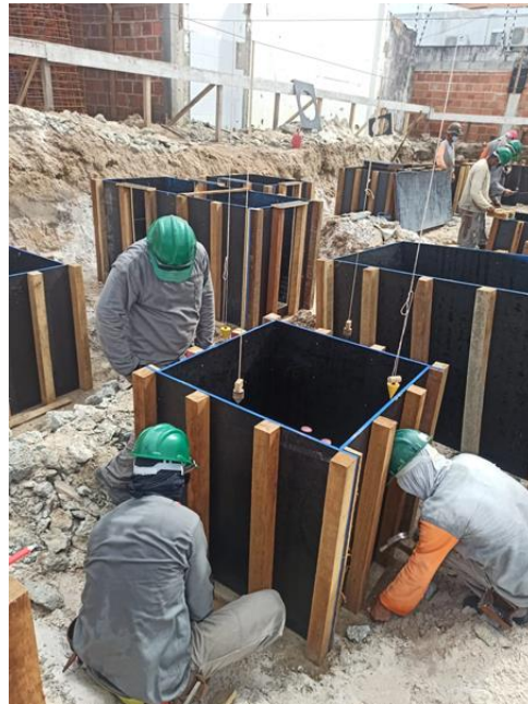
Figura 19 – Fôrmas para blocos de coroamento
