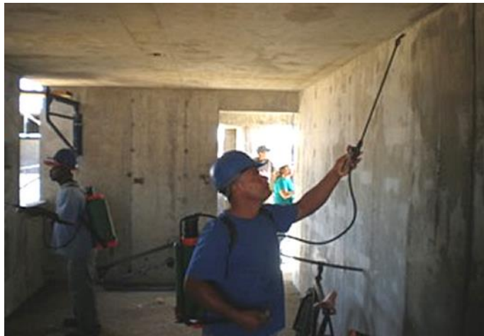
Figura 14 – Execução de cura química
