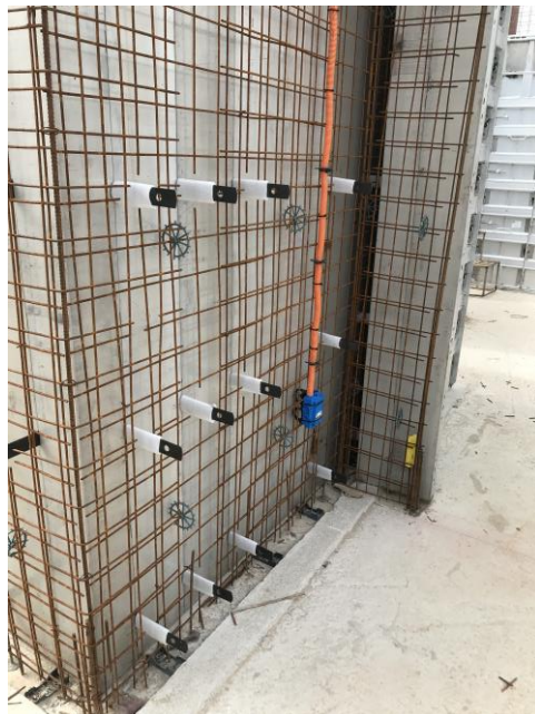
Figura 30 – Fôrmas, faquetas, telas e instalações elétricas
