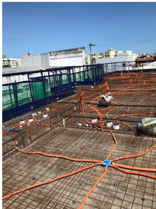
Figura 33 – Armação e instalações de laje concluída
