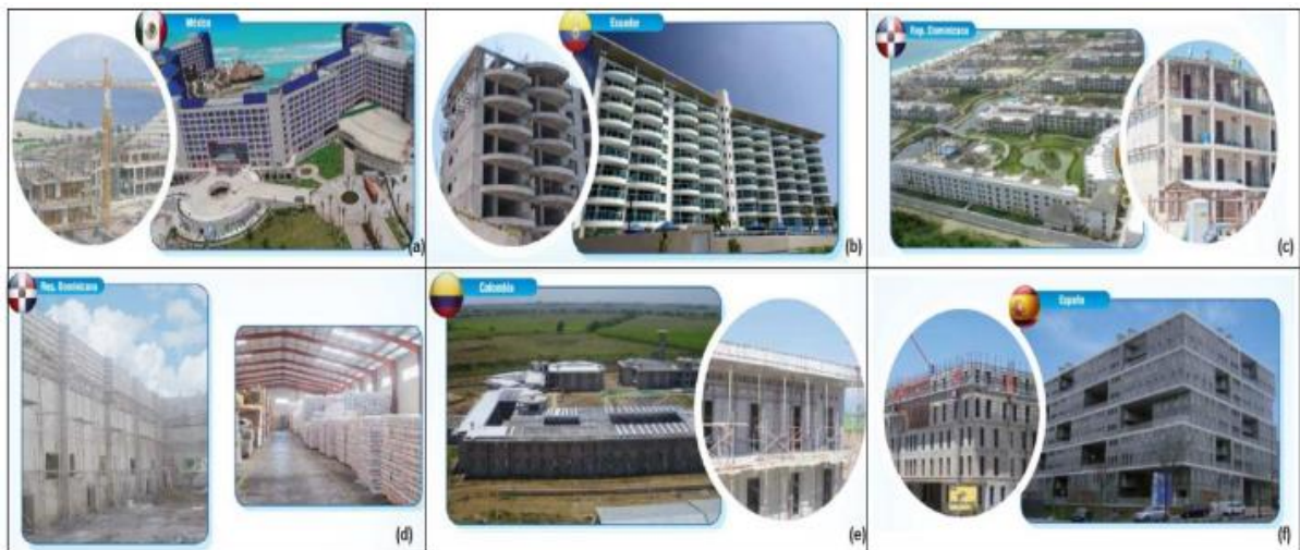
Figura 1 – Obras de grande porte em paredes de concreto
