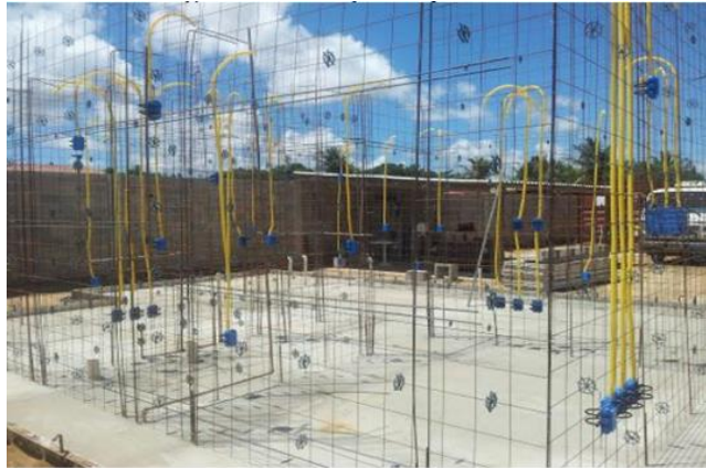
Figura 6 – Tela soldadas e instalações elétricas
