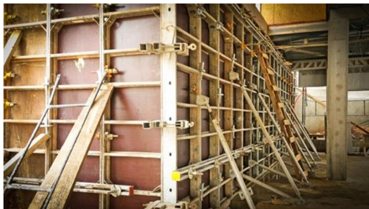
Figura 9 – Fôrmas de madeira
