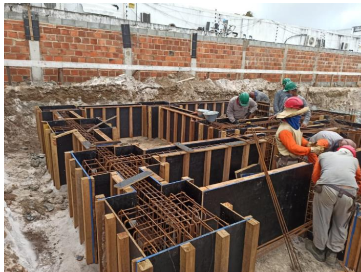
Figura 20 – Fôrmas e armação dos blocos de coroamento e vigas baldrame
