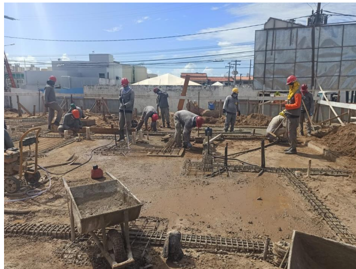
Figura 22 – Reaterro da fundação
