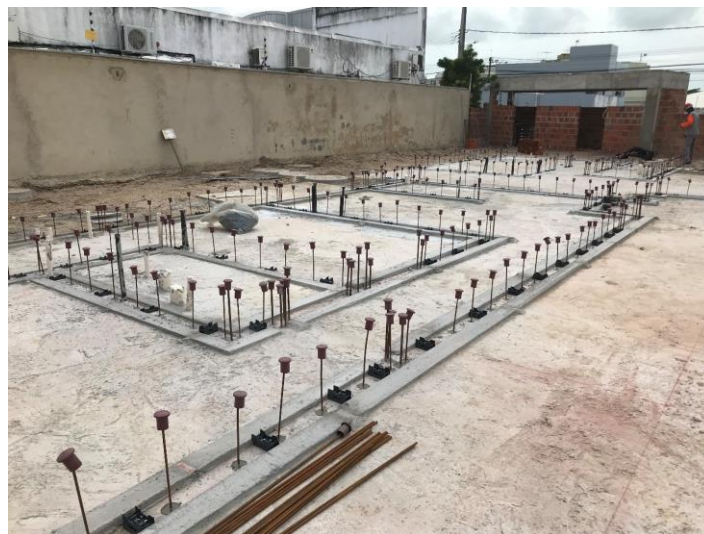
Figura 26 – Laje concretada com ferro de arranques e mestras
