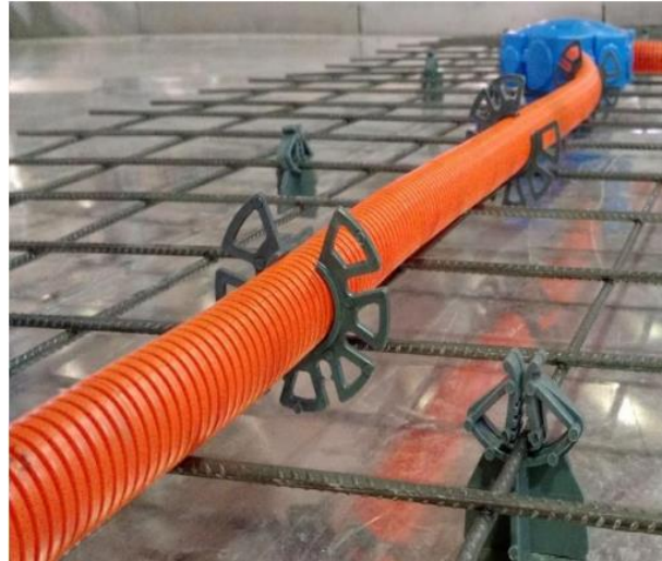
Figura 7 – Instalação elétrica com espaçadores
