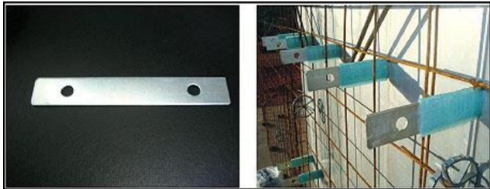
Figura 12 – Faquetas/Corbatas com invólucro de EPS
