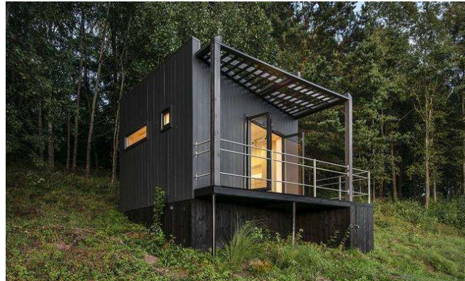
Figura 14 – Exterior da Cabana Etno, de Ema Butrimaviciute.
