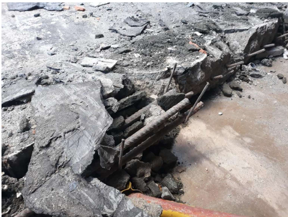
Figura 25 – Contorno demolido da laje
