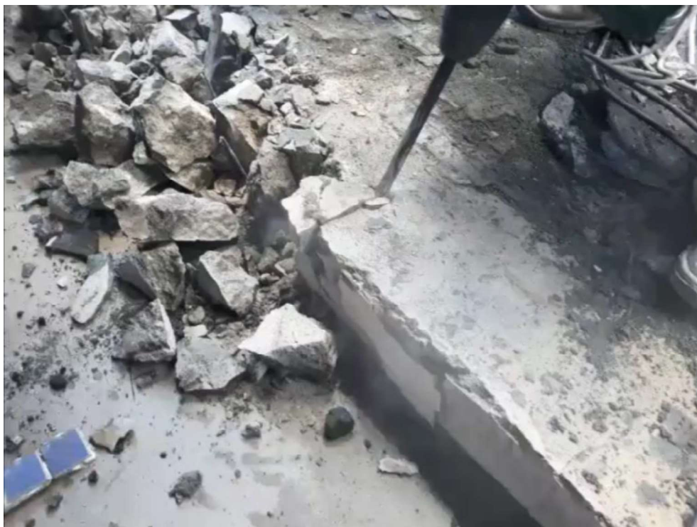
Figura 26 – Demolição do contorno da laje
