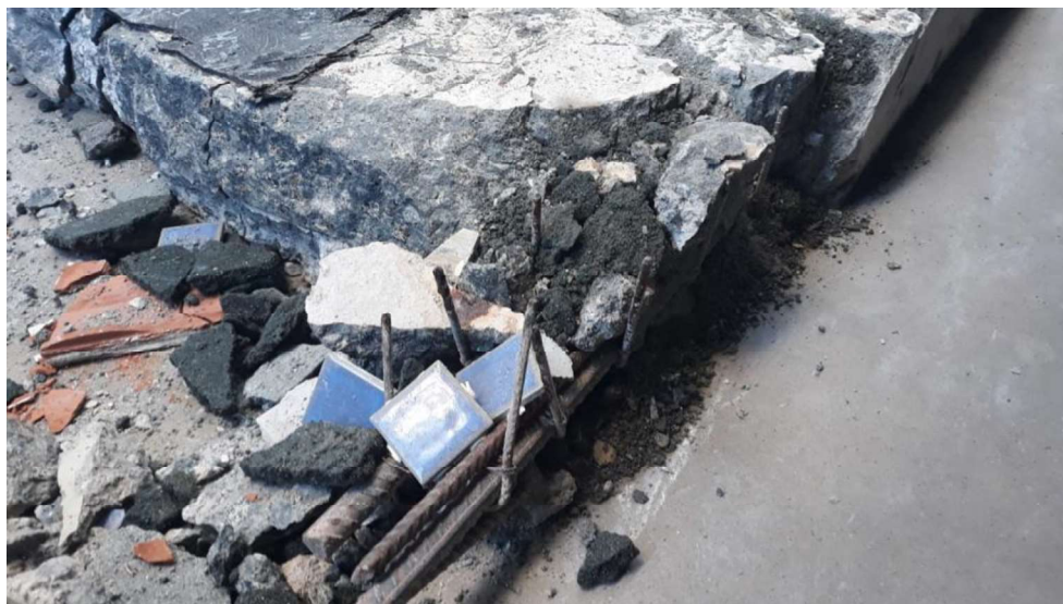
Figura 24 – Contorno demolido da laje
