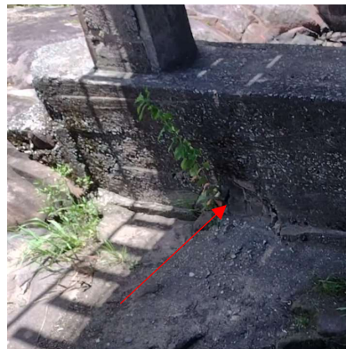
Figura 28 -Sapata corrida EF3 Fonte: Próprio autor (2021)
