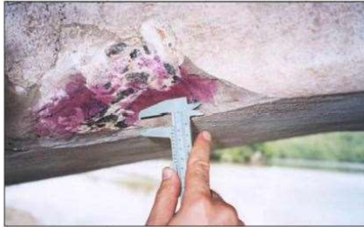
Figura 20 -Ensaio de profundidade de carbonatação Fonte: Mitre (2005)
