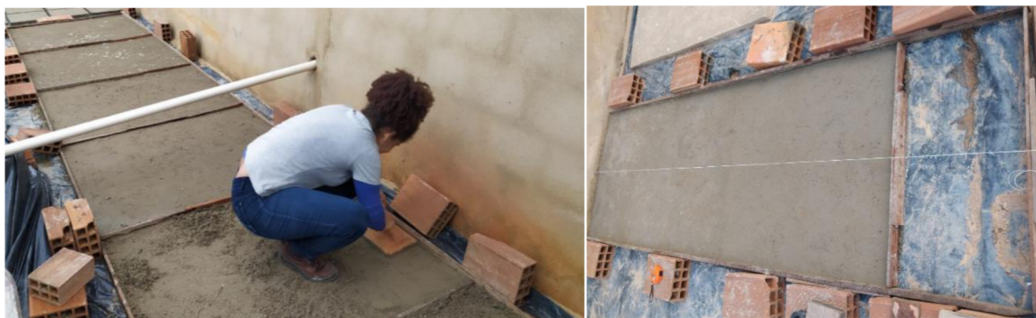
Figura 20 – Confeção dos corpos de prova para análise quanto ao aparecimento de fissuras
