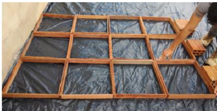
Figura 19 – Fôrmas de madeira Fonte: Autor (2021).
