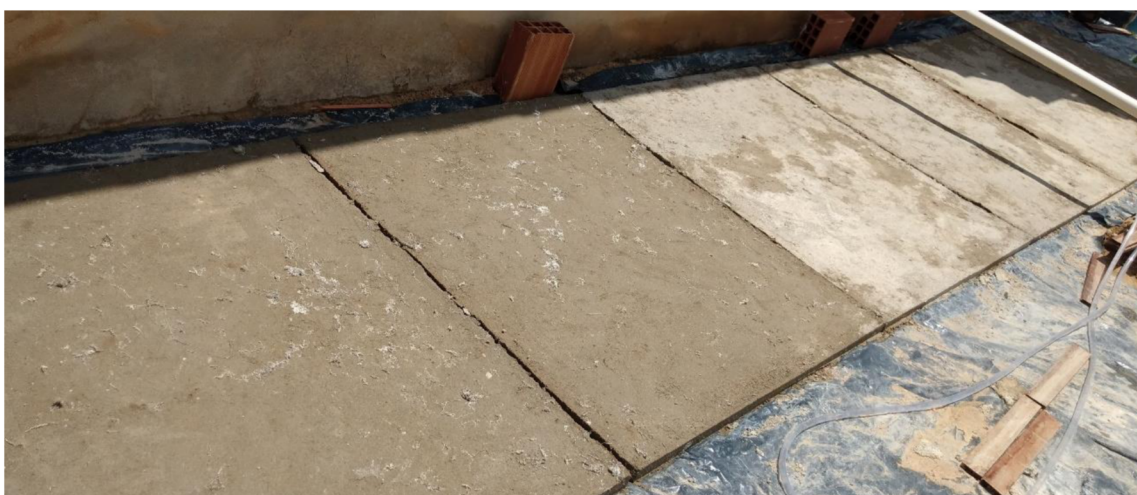
Figura 31 – Placas de argamassa de 1,20 m (comprimento) x 1,00 m (largura) x 0,03 m (espessura), após 14 dias Fonte: Autor (2021).
