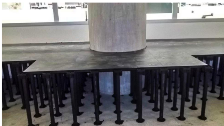
Figura 6 – Piso suspenso em área interna.
