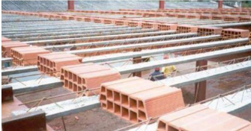
**Figura 7:** Vigotas treliçadas e enchimento com lajota cerâmica. (Fonte: Manual técnico de lajes treliçadas Acerlomittal).
