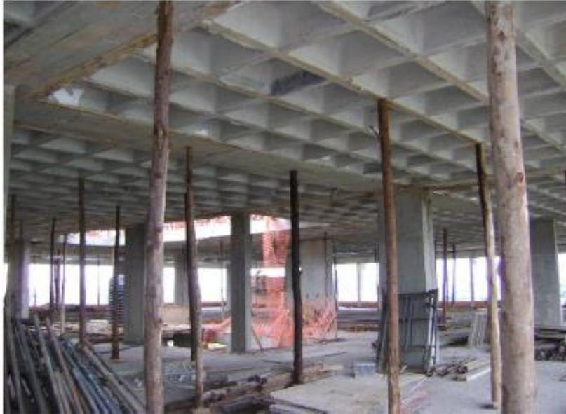
**Figura 2:** Escoramento de madeira eucalipto em laje nervurada. (Fonte: Rezende,2010).
