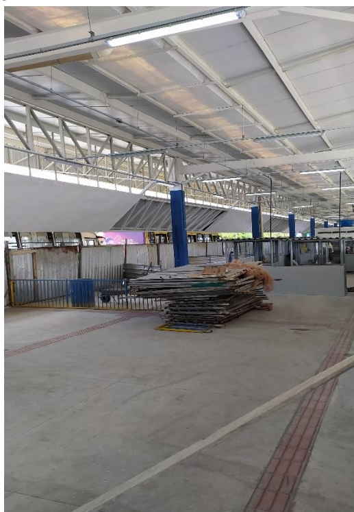
Figura 60 – Obra Parada no Terminal
