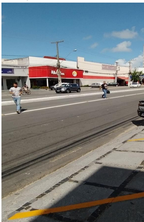
Figura 50 – Ausência de Elementos para Suporte à travessia 01
