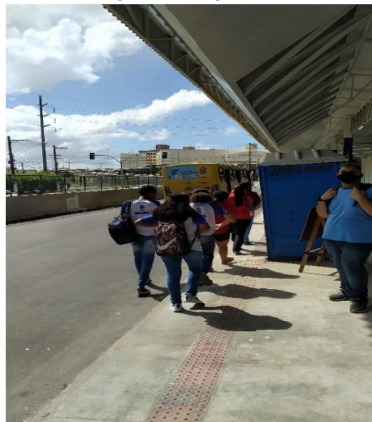
Figura 63 -Banheiros Impedindo a Passagem Segura dos Operantes
