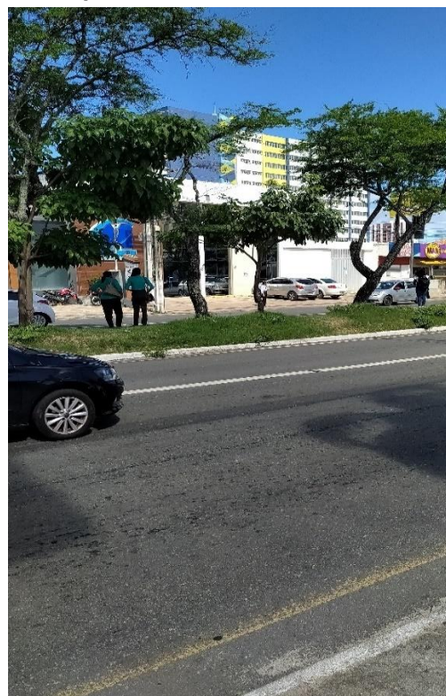
Figura 51 - Ausência de Elementos para Suporte à travessia 02
