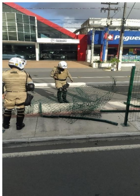
Figura 56 – Tela de Proteção Arrancada Após um Acidentes na Via
