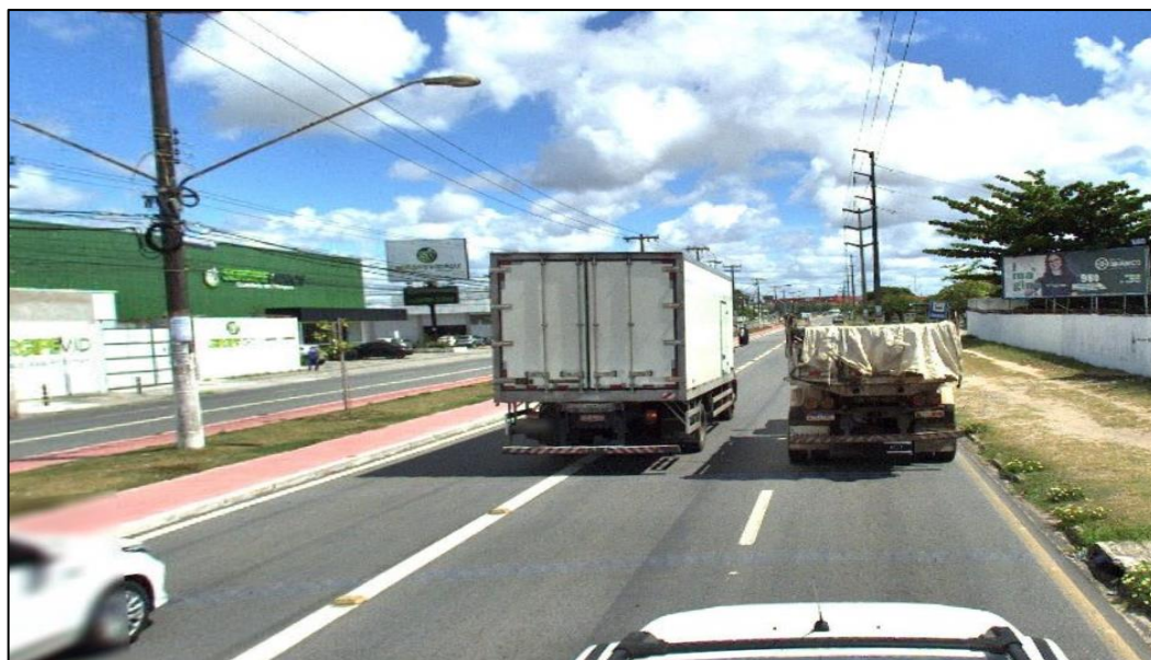
Figura 54 – Conflito na Utilização do Corredor devido ao Estreitamento de Faixas
