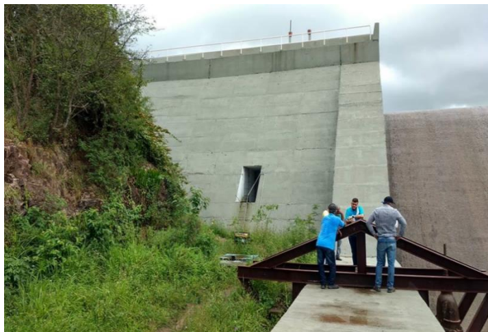
Figura 23 - Vista do paramento de jusante do maciço direito, onde está localizado o acesso à galeria de inspeção e drenagem da Barragem Jacarecica I.
