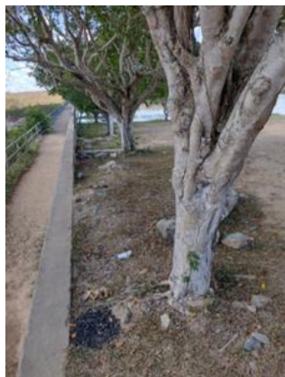
Foto 28 - Acesso a ombreira esquerda do barramento, com presença de vegetação arbórea (tronco - \varnothing \geq 0,5 m).
