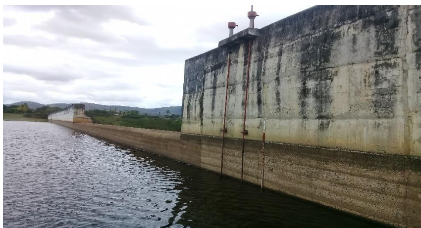
Figura 14 - Paramento de Montante da Barragem Jacarecica I em Itabaiana/SE.
