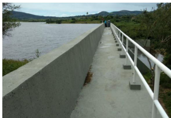
Foto 11 - Vista da crista da barragem Jacarecica I, com detalhe da mureta de concreto à montante e guarda-corpo à jusante.
