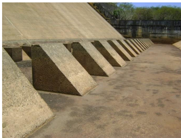
Foto 5 - Bacia de Dissipação da Barragem Jacarecica I em Itabaiana/SE.
