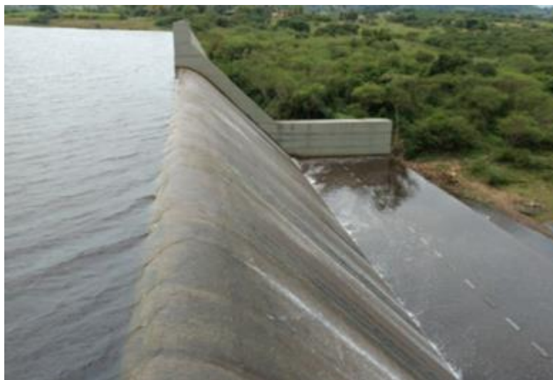
Foto 12 - Vertedouro da barragem Jacarecica I.
