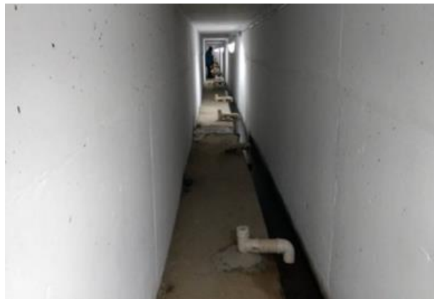
Foto 10 - Vista interna da galeria de inspeção e drenagem da barragem Jacarecica I.
