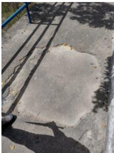
Foto 27 - Passeio de acesso a crista do maciço pela parte superior da ombreira esquerda.
