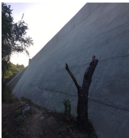
Figura 11 - Maciço da Barragem Jacarecica I em Itabaiana/SE.
