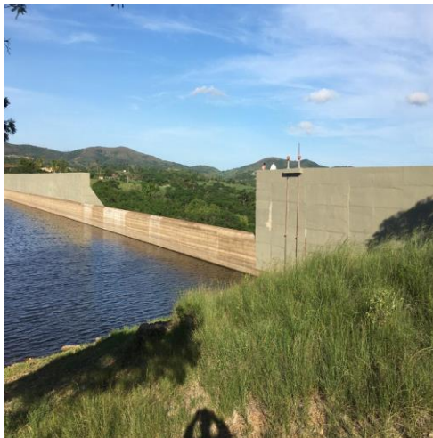
Figura 12 - Ombreiras do Maciço da Barragem Jacarecica I em Itabaiana/SE.
