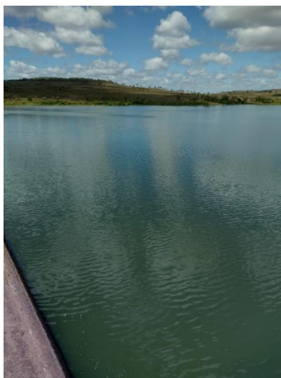
Foto 36 - Reservatório barrado com aproximadamente 15.000.000 m 3 d'água.
