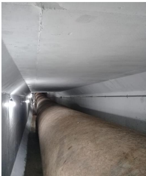
Figura 8 - Tubulação de Tomada D'Água da Barragem Jacarecica II em Malhador/SE.
