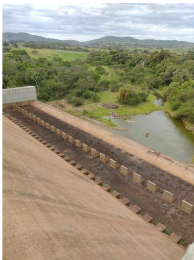
Foto 16 - Bacia de dissipação a jusante do maciço com sistema de enrocamento artificial (soleira dentada).
