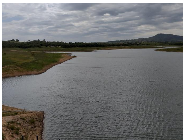
Foto 21 - Reservatório barrado com aproximadamente 4.700.000 m 3 d'água.
