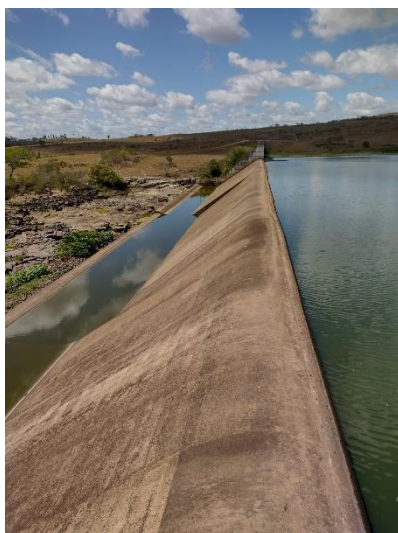
Foto 9 - Vertedouro da barragem Gov. Dionísio Machado.
