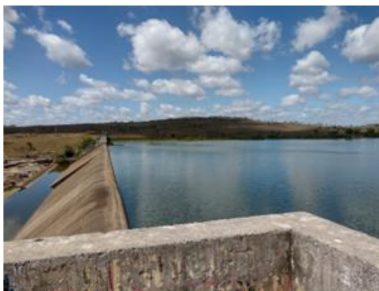
Foto 8 - Crista esquerda da barragem Gov. Dionísio Machado.
