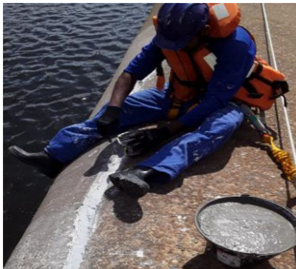
Figura 19 - Projeção de Argamassas Poliméricas no Vertedouro da Barragem Jacarecica I em Itabaiana/SE.
