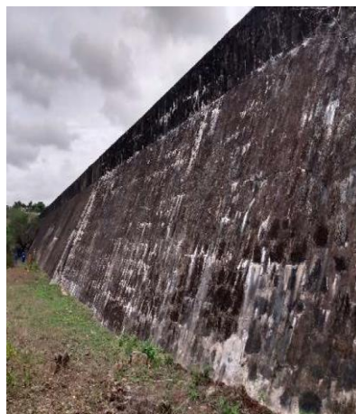
Figura 13 - Paramento de Jusante da Barragem Jacarecica I em Itabaiana/SE.
