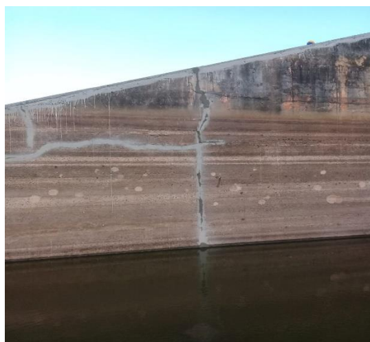
Figura 20 - Impermeabilização e Selamento de Fissuras na Ombreira da Barragem Gov. João Alves Filho em Itabaiana /SE.
