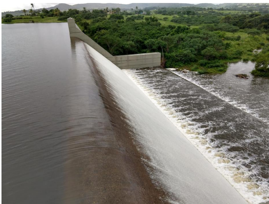
Foto 1 - Vertedouro da Barragem Jacarecica I em Itabaiana/SE.
