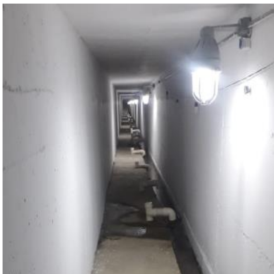
Figura 10 - Galeria de Drenagem da Barragem Jacarecica I em Itabaiana/SE.
