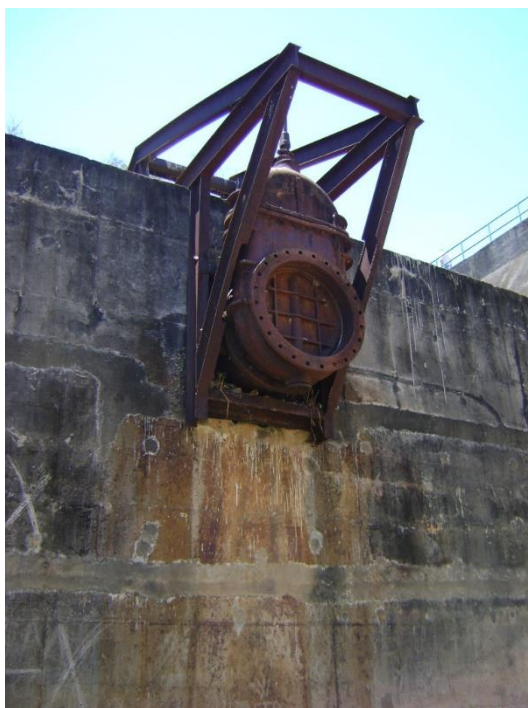
Foto 2 - Descarga de Fundo da Barragem Jacarecica I em Itabaiana/SE.
