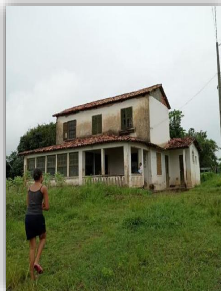
Figura 38 – Antiga Casa Grande da comunidade Remanescente de Quilombo Pirangi
