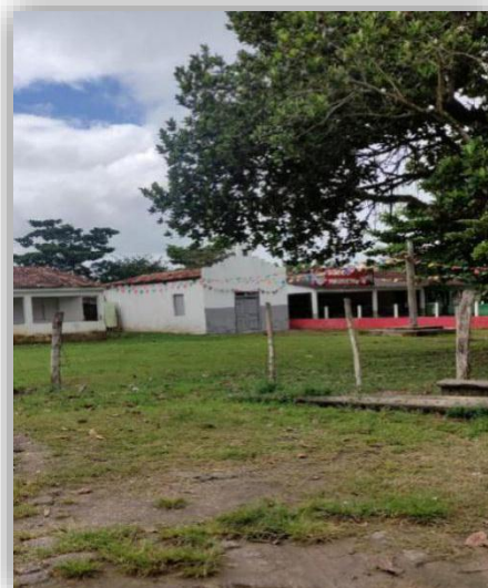
Figura 19- Igreja São João da Comunidade Quilombola Terra Dura /Coqueiral
