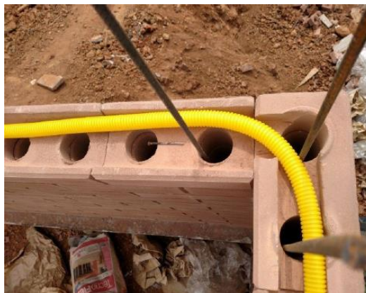
Figura 2 - Passagem de instalação elétrica na parede de tijolo solo cimento (SILVA, 2019).
