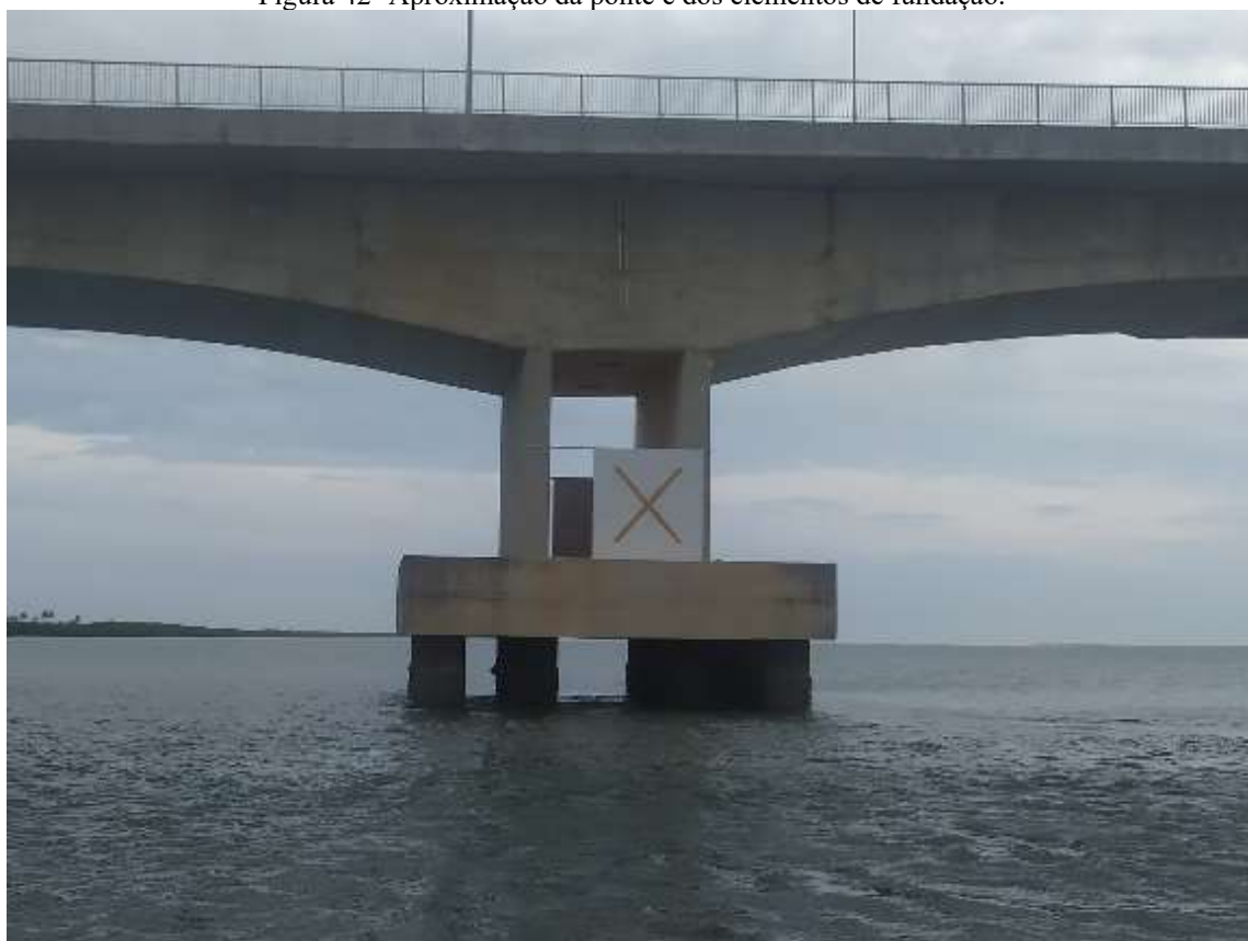
Figura 42- Aproximação da ponte e dos elementos de fundação.
