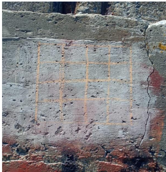
Figura 16 – Marcação na estrutura para realização dos impactos com o esclerômetro
