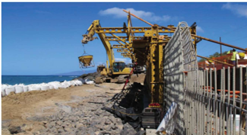
Figura 9: Paredão que protege a Rodovia Honoapiilani em Maui no Havaí.
