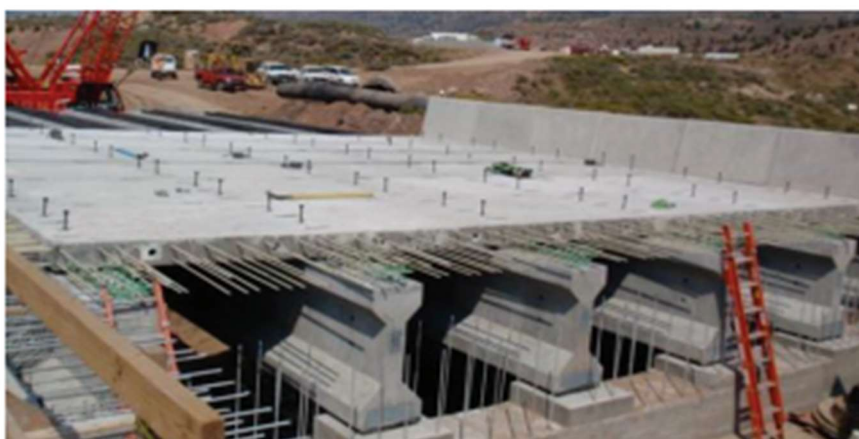
Figura 8: Ponte Emma Park.
