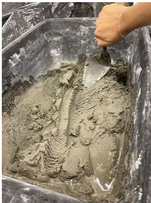
Imagem 11 - Verificação da plasticidade da argamassa
