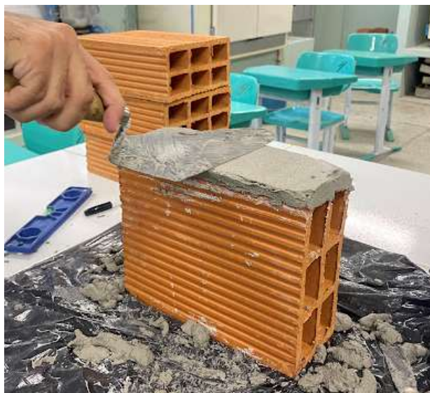
Imagem 13 - Aplicação de argamassa para união dos blocos cerâmicos
