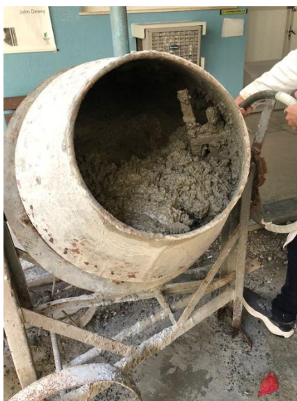
Figura 25 – Mistura do material em betoneira.
