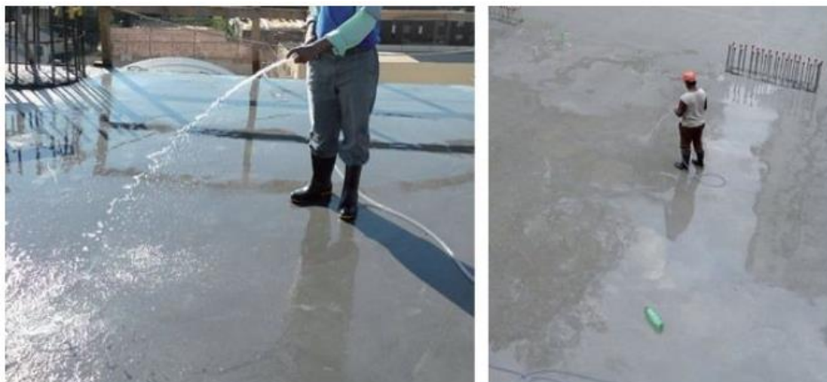
Figura 19 – Cura úmida do concreto por molhagem contínua.
