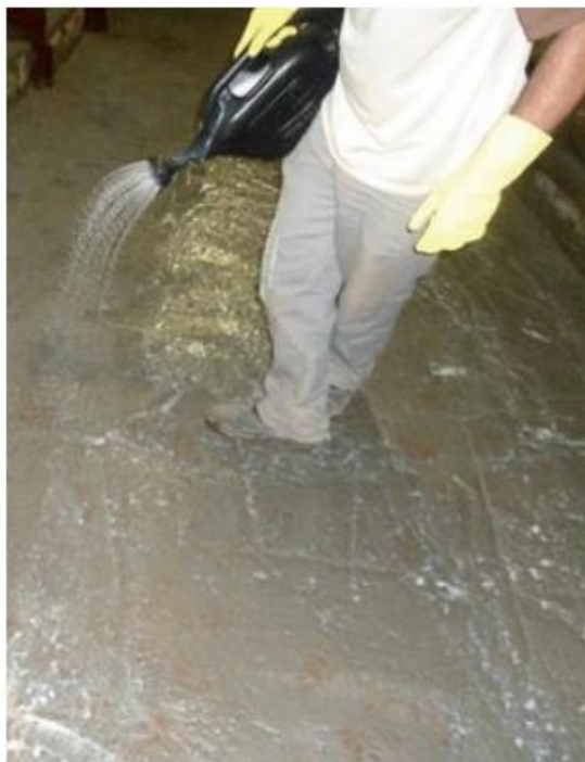
Figura 21 – Aplicação de produto para realização da cura química.
