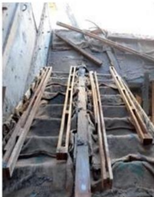
Figura 20 – Cura do concreto com utilização de sacos de aniagem.
