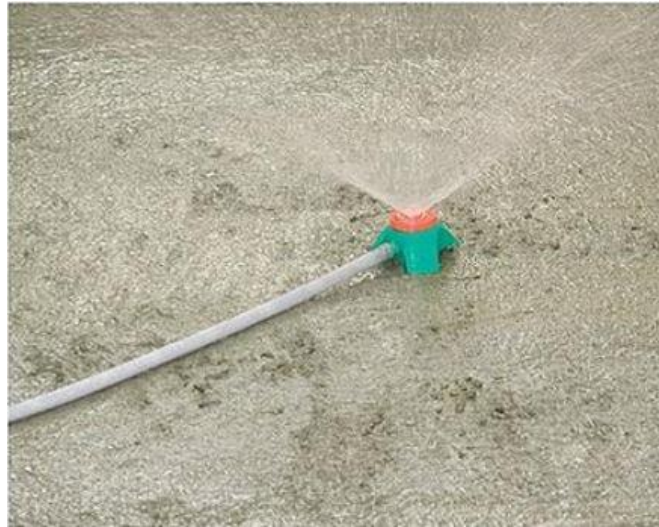
Figura 11 - Cura úmida com uso de aspersor.
