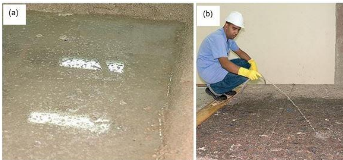
Figura 12 - (a) Cura por alagamento; (b) Cura com manta saturada.
