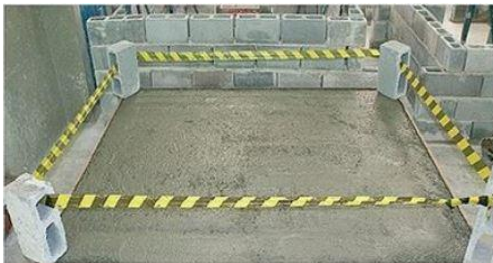
Figura 9 - Isolamento de concreto recém-lançado para evitar solicitações prematuras.
