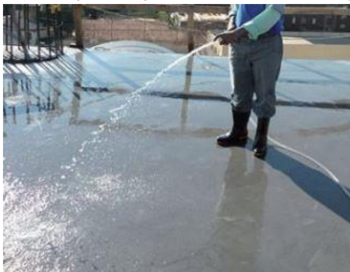
Figura 10 - Cura por molhagem constante com uso de mangueira.
