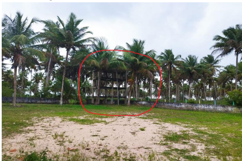
Figura 17 – Estrutura do reservatório elevado do Povoado
