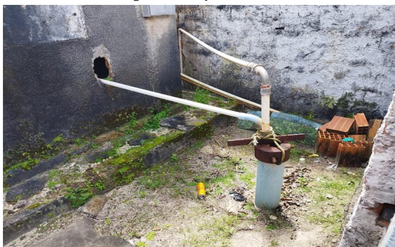
Figura 18 – Poço ativado do Povoado
