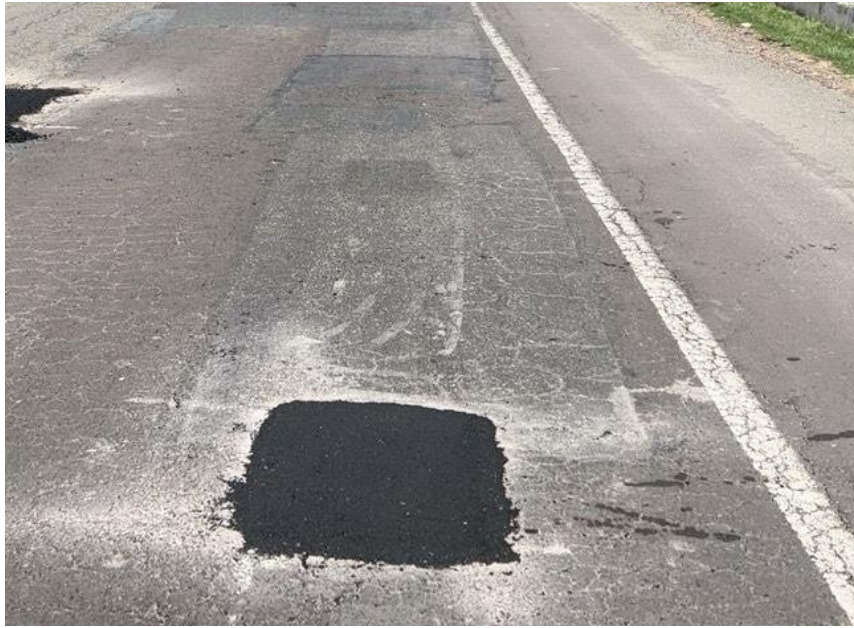
Foto 20 - Reparo localizado no km 87 (sentido decrescente).
