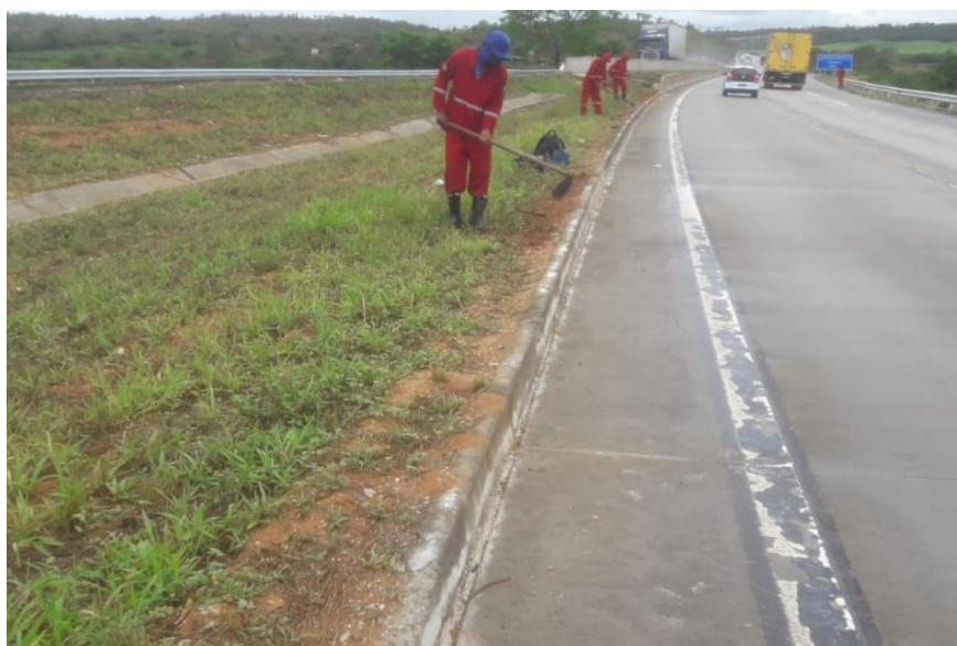
Foto 14 - Serviço de capina e limpeza de meio-fio no km 30.
