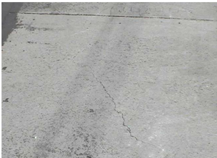
Figura 25 - Fissuras superficiais.
