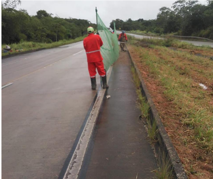
Foto 8 - Serviço de roçada costal no km 44 (sentido crescente).
