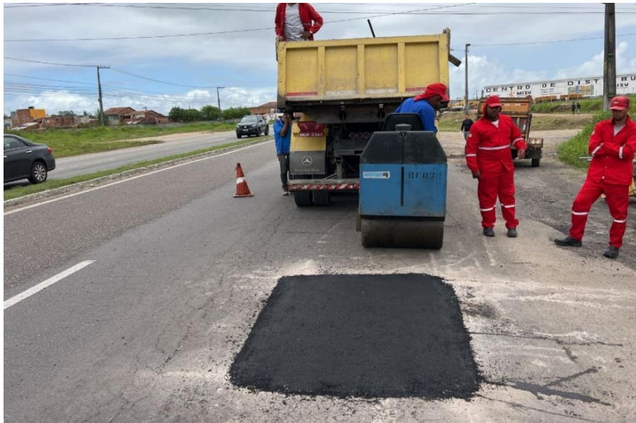
Foto 29 - Reparo localizado no km 93 (sentido decrescente).
