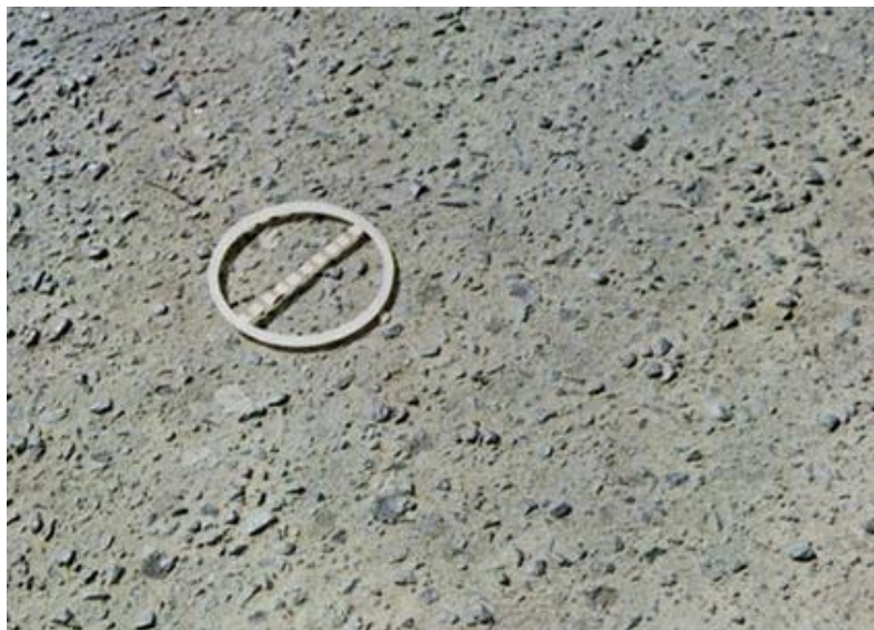
Figura 12 - Desgaste.
