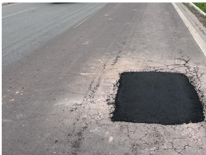
Foto 30 - Reparo localizado no km 78 (sentido decrescente).
