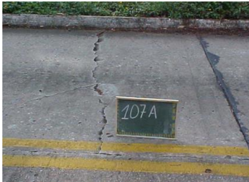
Figura 18 - Fissuras transversais.
