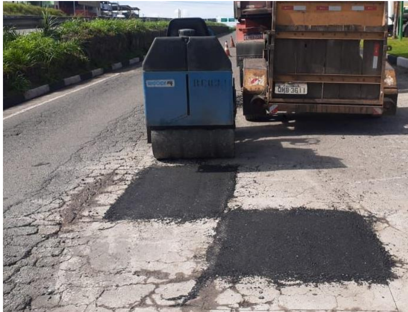
Foto 18 - Etapa de compactação do serviço de reparo localizado no km 90 (sentido decrescente).
