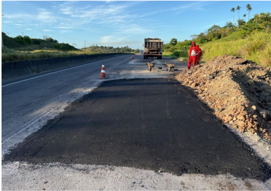
Foto 24 - Serviço de remendo profundo no km 83 (sentido decrescente).
