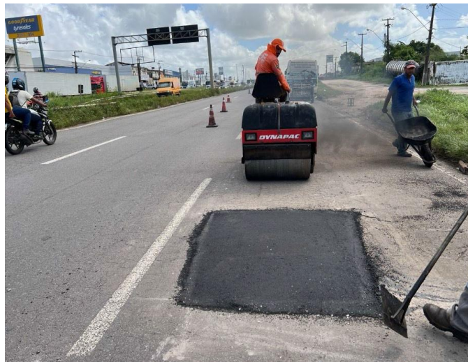
Foto 2 - Tapa buraco em panela da BR-101/SE.
