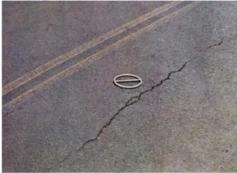
Figura 6 - Trinca longitudinal.
