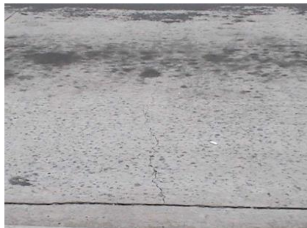
Figura 23 - Desgaste superficial.
