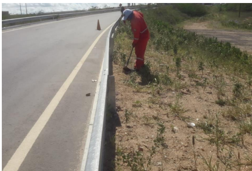
Foto 27 - Capina e limpeza de meio-fio no km 03 (sentido crescente).
