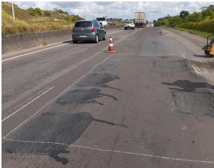
Foto 23 - Marcação de remendo profundo no km 83 (sentido decrescente).
