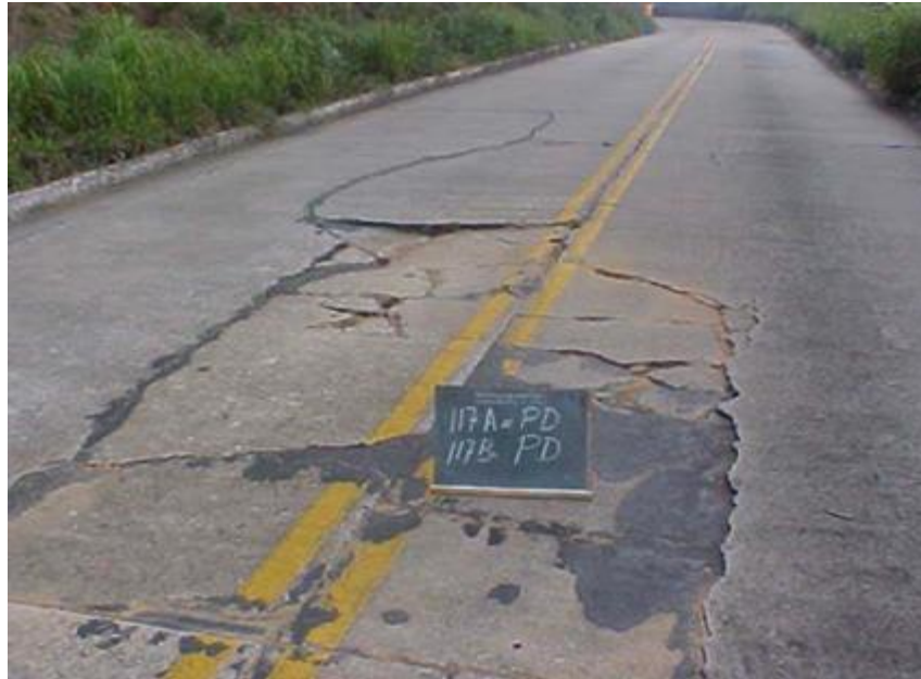
Figura 16 - Placa dividida.
