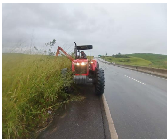
Foto 3 - Roçada mecanizada com roçadeira.
