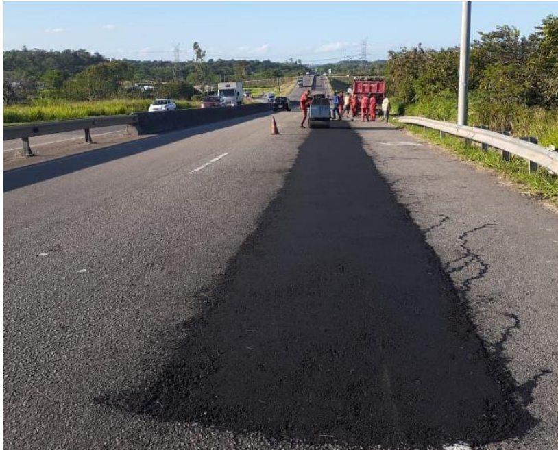
Foto 22 - Correção de defeitos no km 85 (sentido decrescente).
