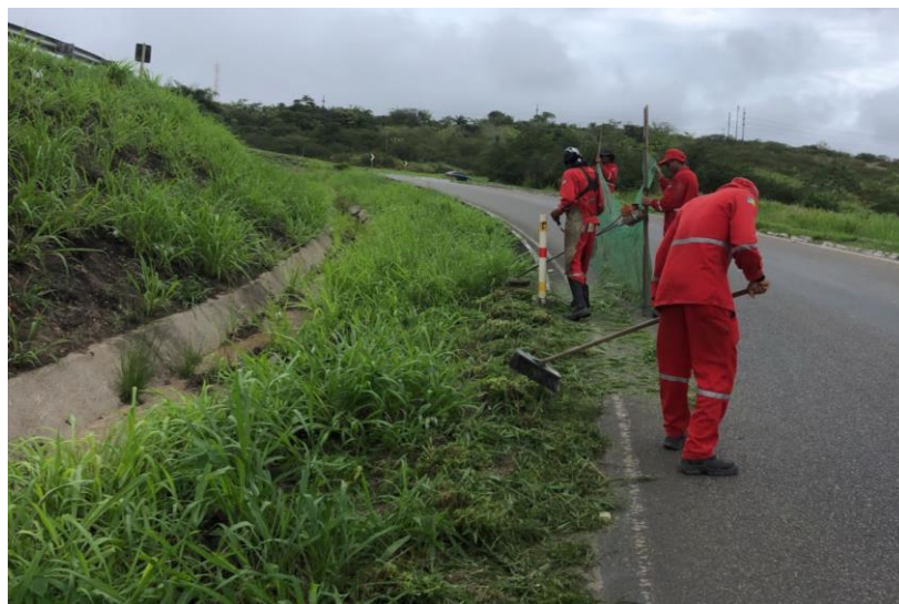
Foto 16 - Serviço de roçada costal no km 89 (alça do viaduto).
