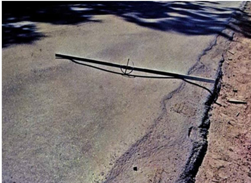
Figura 8 - Afundamento.
