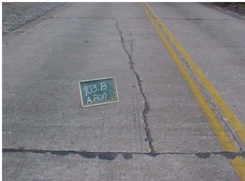
Figura 19 - Fissuras longitudinais.
