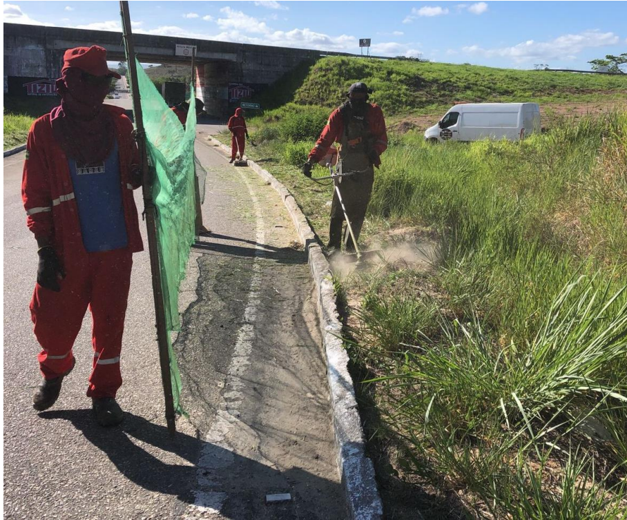
Foto 15 - Serviço de roçada costal no km 81.
