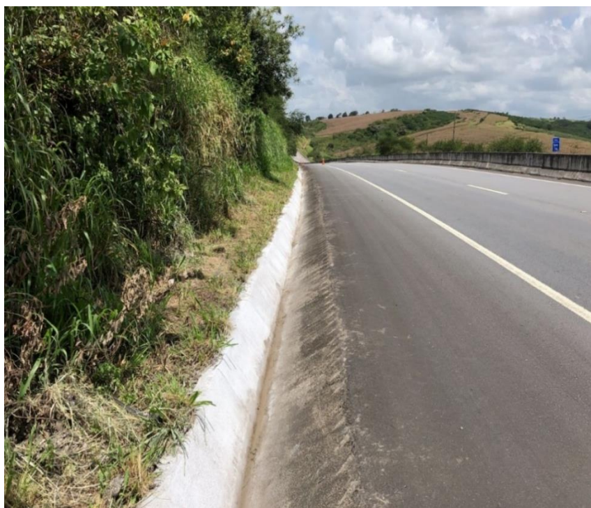
Foto 5 - Sarjeta desobstruída no km 16 (sentido decrescente).
