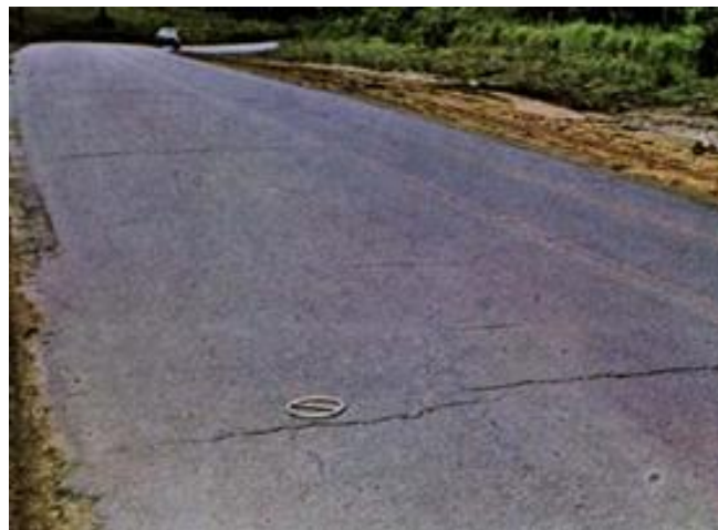
Figura 7 - Trinca transversal.
