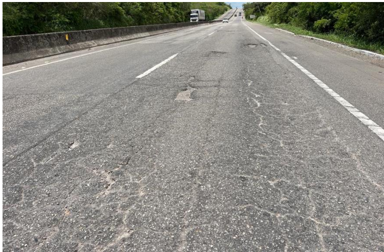
Foto 31 - Vista do km 79 (sentido decrescente).
