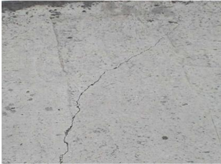
Figura 20 - Fissuras diagonais.
