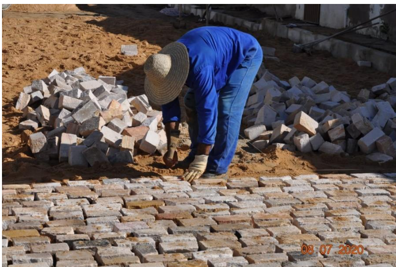
Figura 14 – Calçamento em paralelepípedo
