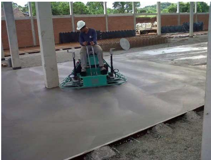
Figura 15 – Piso em concreto
