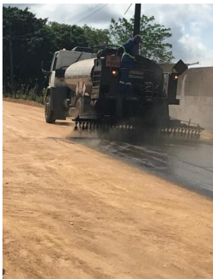
Figura 32 – Imprimação/Espargidor
