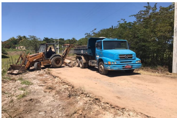
Figura 27 – Limpeza manual da via
