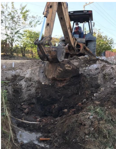
Figura 28 – Escavação de vala
