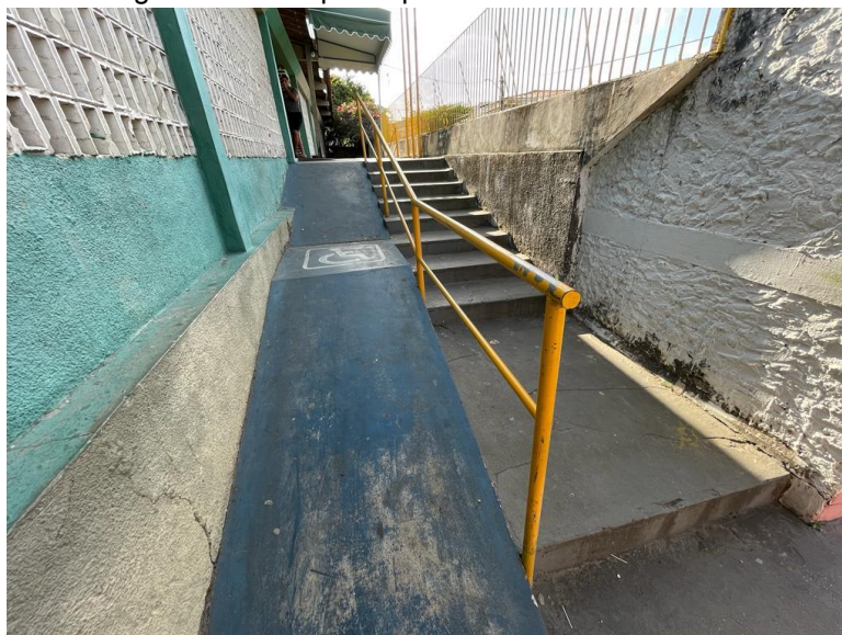
Figura 17 - Rampa do portão à entrada da escola
