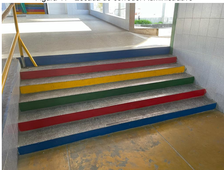
Figura 11 - Escada do corredor Administrativo
