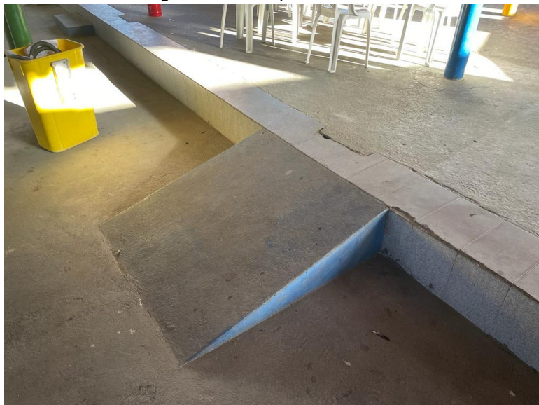
Figura 18 - Rampa do refeitório
