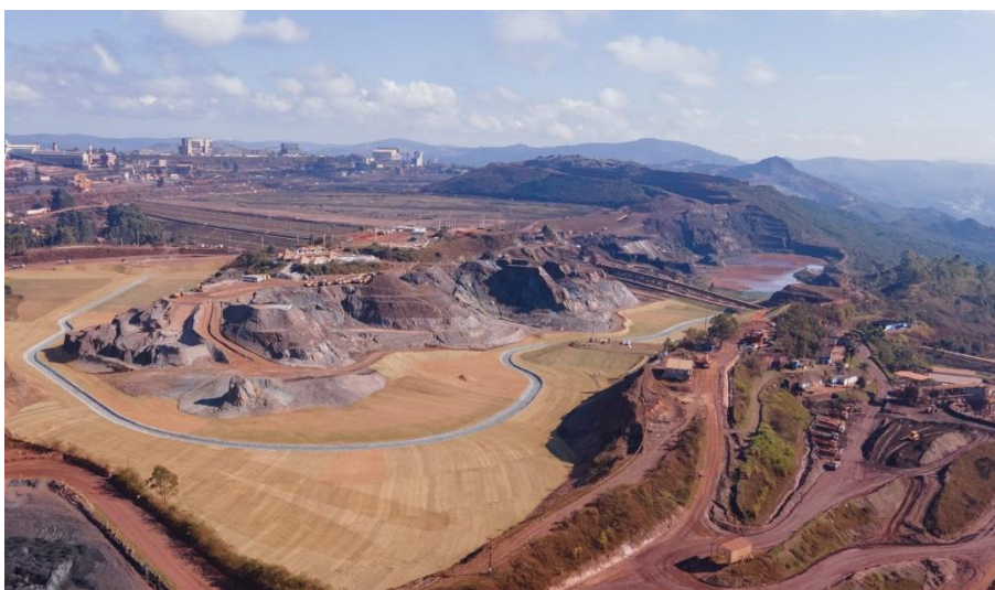
Figura 5 - Barragem Fernandinho em Nova Lima/MG
