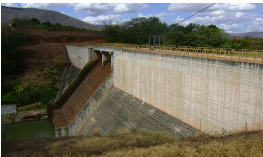
Figura 8 - Barragem Caraíbas em Salinas/MG
