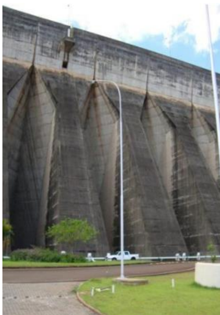
Figura 11 - Usina Hidroelétrica Itaipu Binacional - Trecho D
