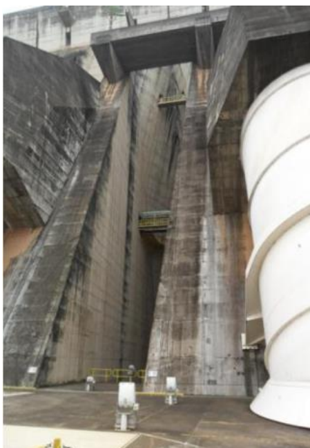
Figura 9 - Usina Hidroelétrica Itaipu Binacional - Trecho principal
