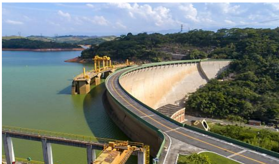
Figura 10 - Usina Hidrelétrica do Funil/RJ do tipo abóboda com dupla curvatura
