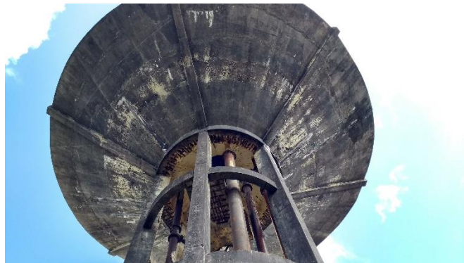
Figura 27 - Vista das lajes de fundo do reservatório Fonte: Autor (2021)
