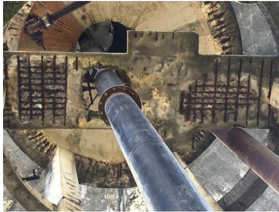
Figura 26 - Vista inferior da laje do patamar Fonte: Autor (2021)
