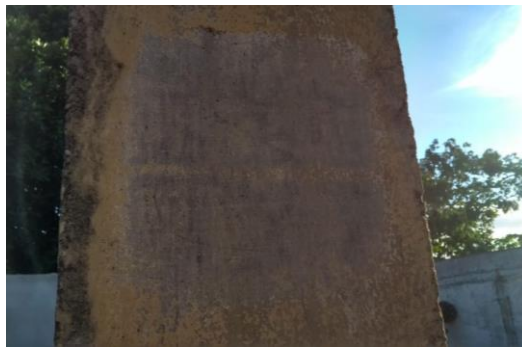
Figura 36 - Região de ensaio do pilar 05 Fonte: Autor (2021)
