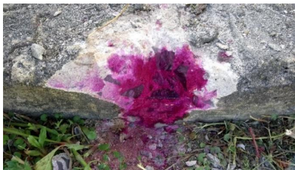
Figura 37 - Ensaio de carbonatação em cinta do reservatório Fonte: Autor (2021)
