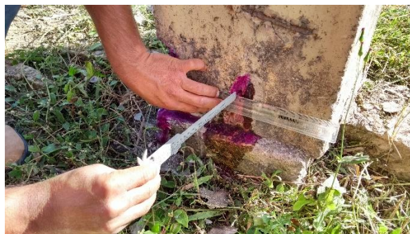
Figura 21 - Verificação do cobrimento da armadura Fonte: Autor (2021)
