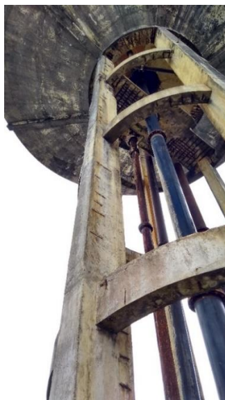
Figura 34 - Vista do pilar 02 Fonte: Autor (2021)
