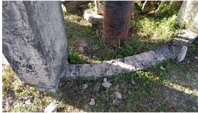
Figura 24 - Cinta em concreto armado Fonte: Autor (2021)
