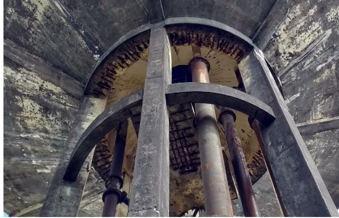
Figura 22 - Vista da manifestações patológicas existentes na viga Fonte: Autor (2021)
